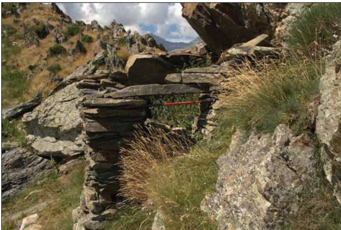
Figura 118. Imatge de construcció des de l'est amb el llindar de la porta.
