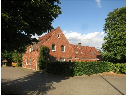
ehemaliges Gasthaus, Blick von der K 27 nach Westen
