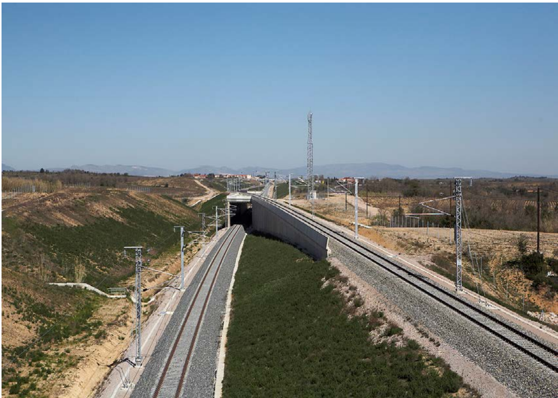
Figura 12. Salto de carnero en la línea de alta velocidad de Figueres a Perpignan para pasar de la circulación por la derecha en España a la circulación por la izquierda en Francia
