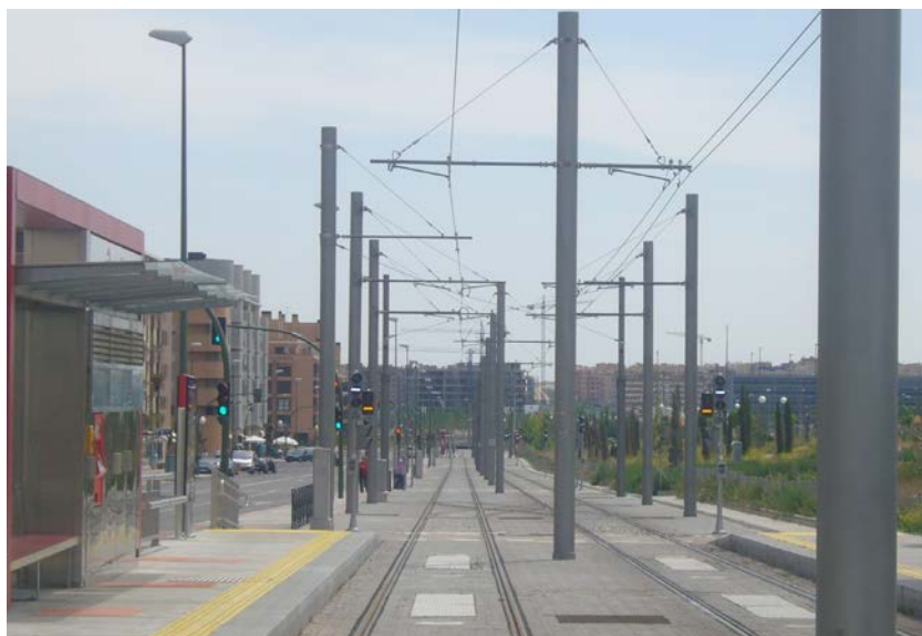
Figura 3. Postes en el centro de la doble vía en línea de Metro Ligero
