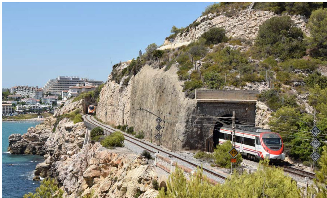
Figura 9. Vía doble con las vías separadas - Cruce de trenes de cercanías a la salida de Sitges lado Barcelona
