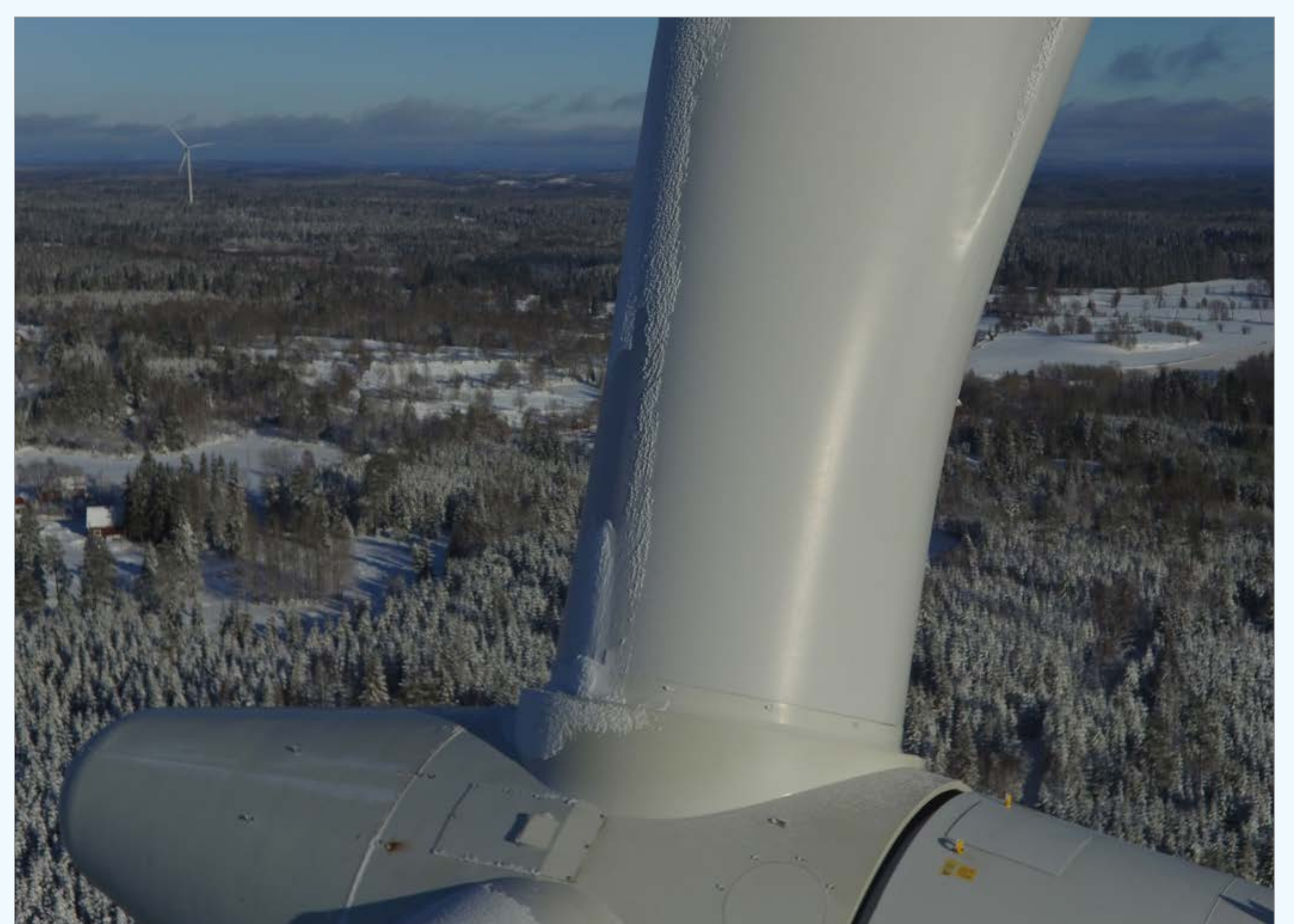
Isbildning på vindkraftverk
