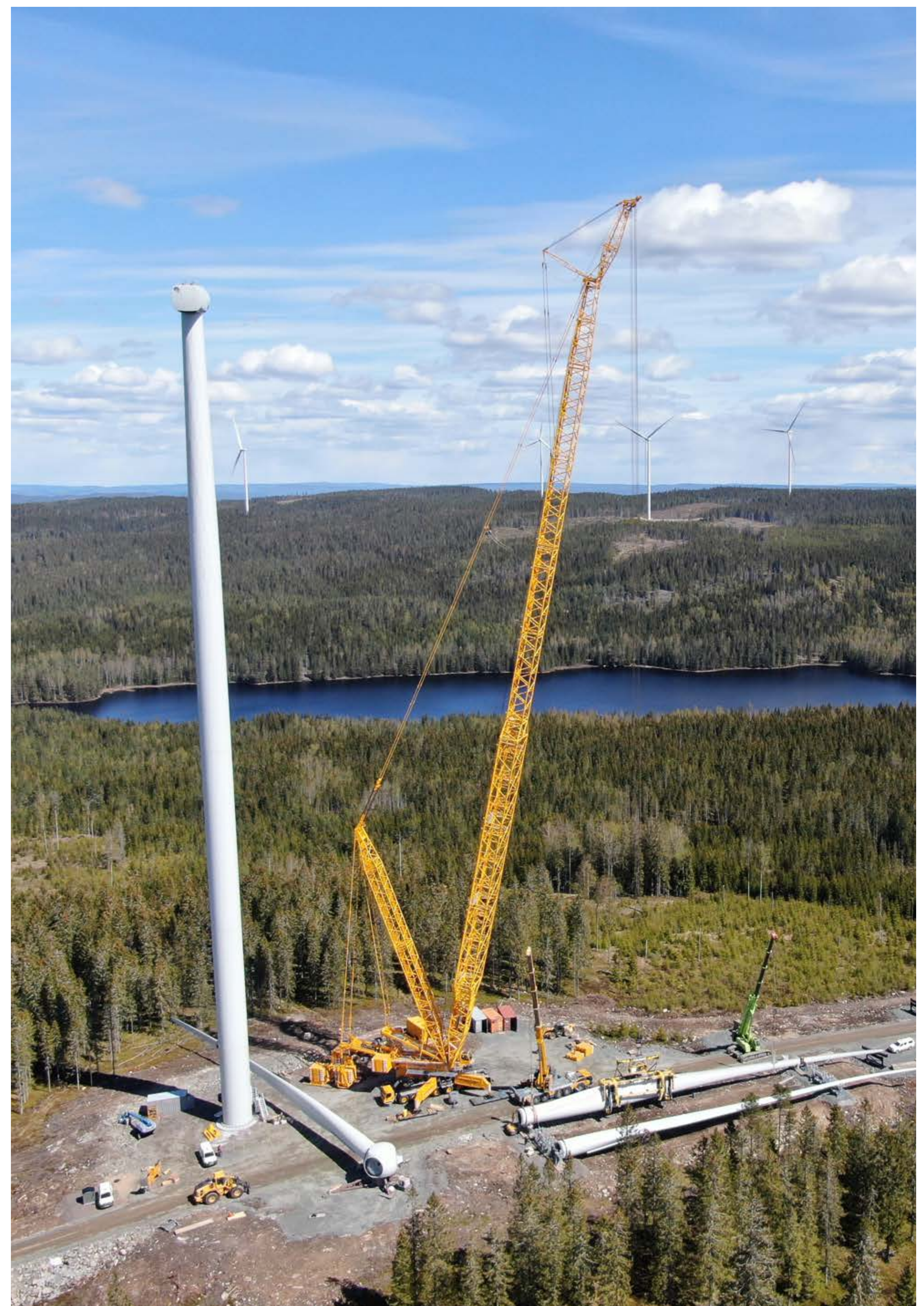
Montering av vindkraftverkets blad
