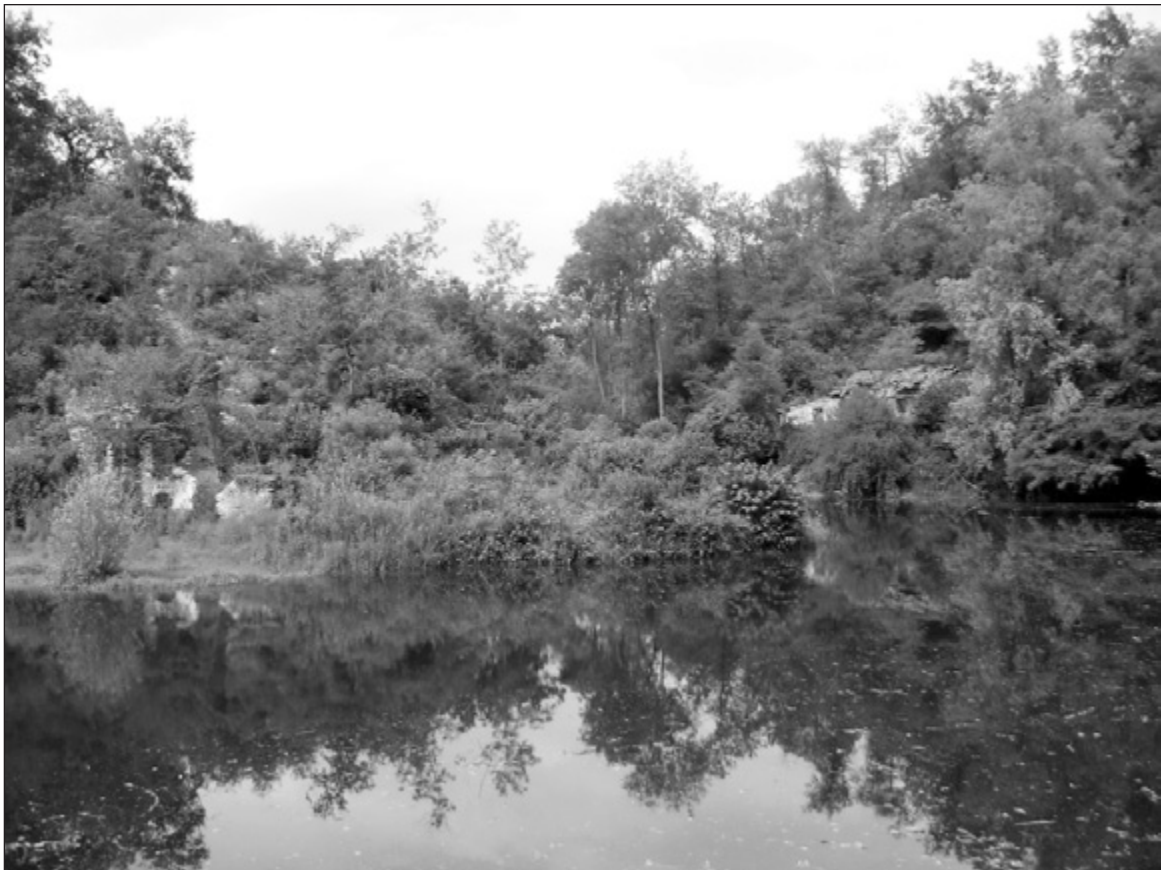
L'invaso della diga con i ruderi di un mulino.
