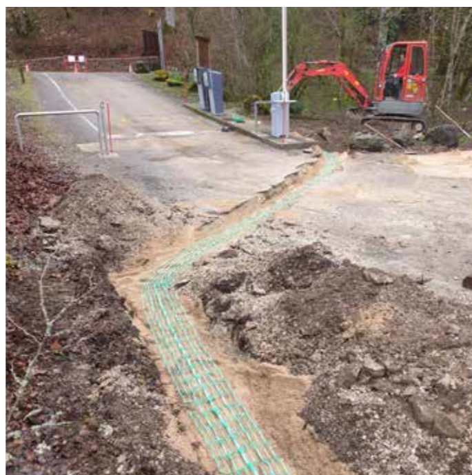
Site des cascades : des gros travaux de terrassement réalisés en régie, pour le passage de la fibre et l'amélioration des différents réseaux.
