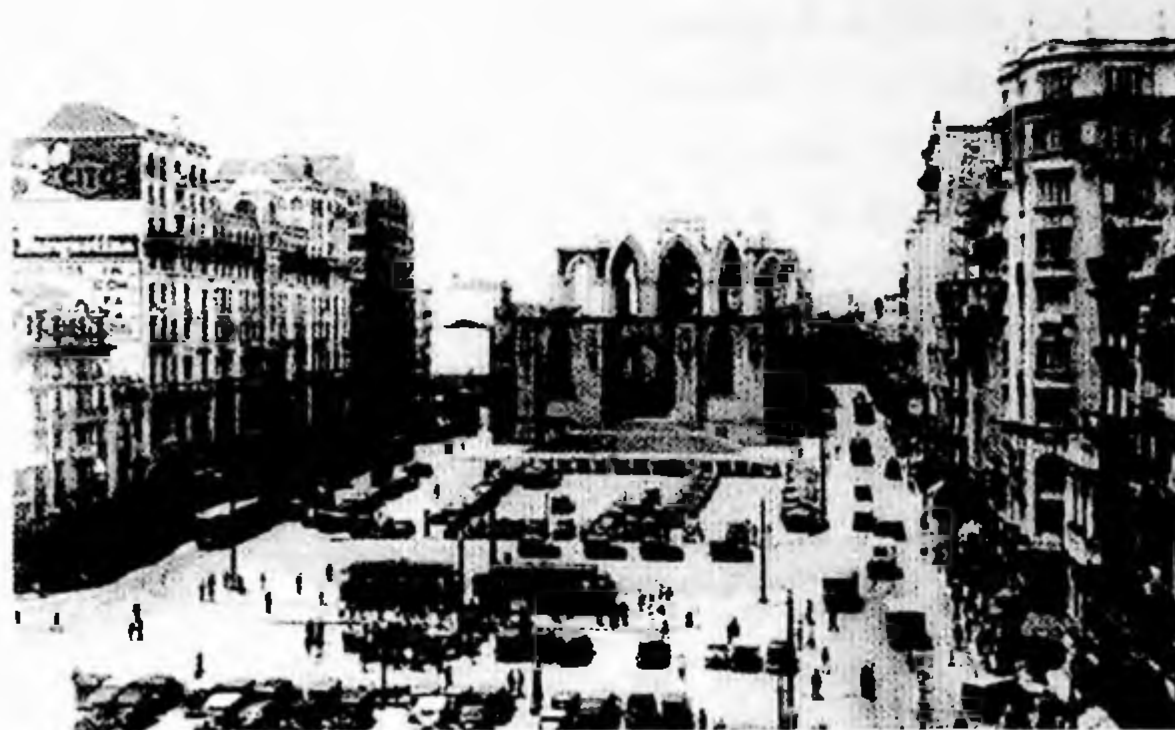
Fig 44 – Praça da Sé em 1933, onde vê-se a Catedral em obras e veículos estacionados no espaço aberto à sua frente.
