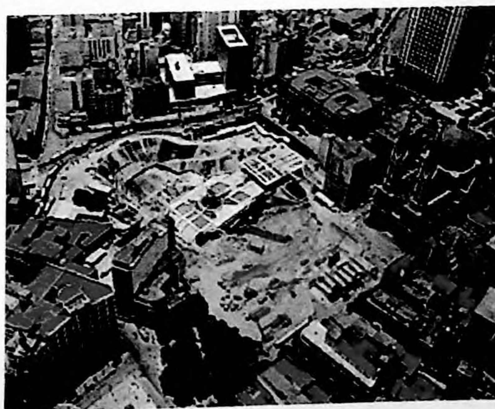
Fig 79 – Vista do mesmo local, em 1975, com as obras da estação em andamento.
