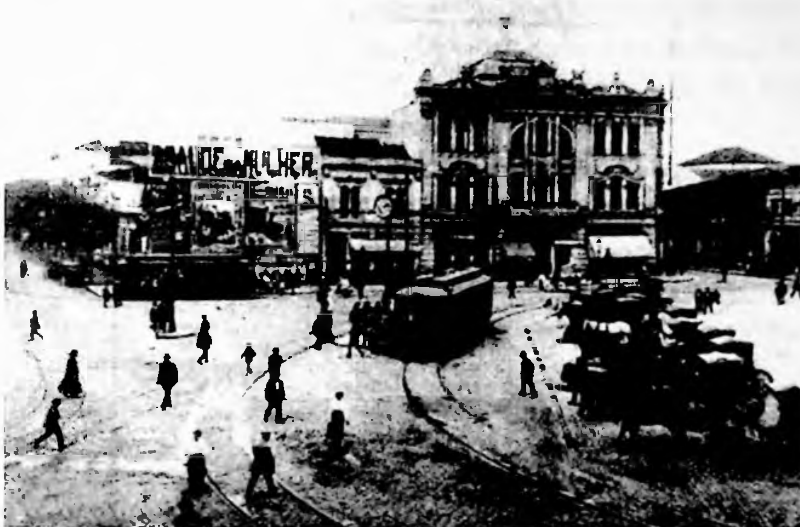
Fig 35 – Imagem da Praça da Sé, após as demolições e alargamentos, 1916.
