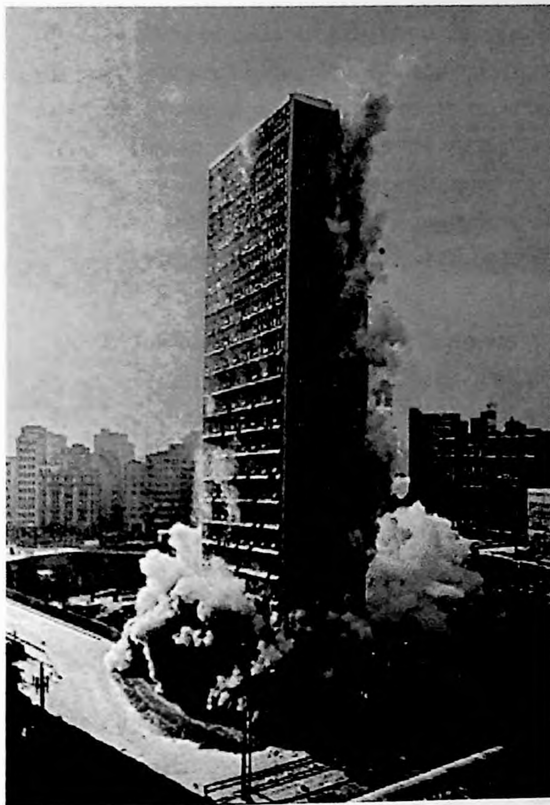
Fig 81 – Implosão do edifício Mendes Caldeira, de 30 pavimentos.
