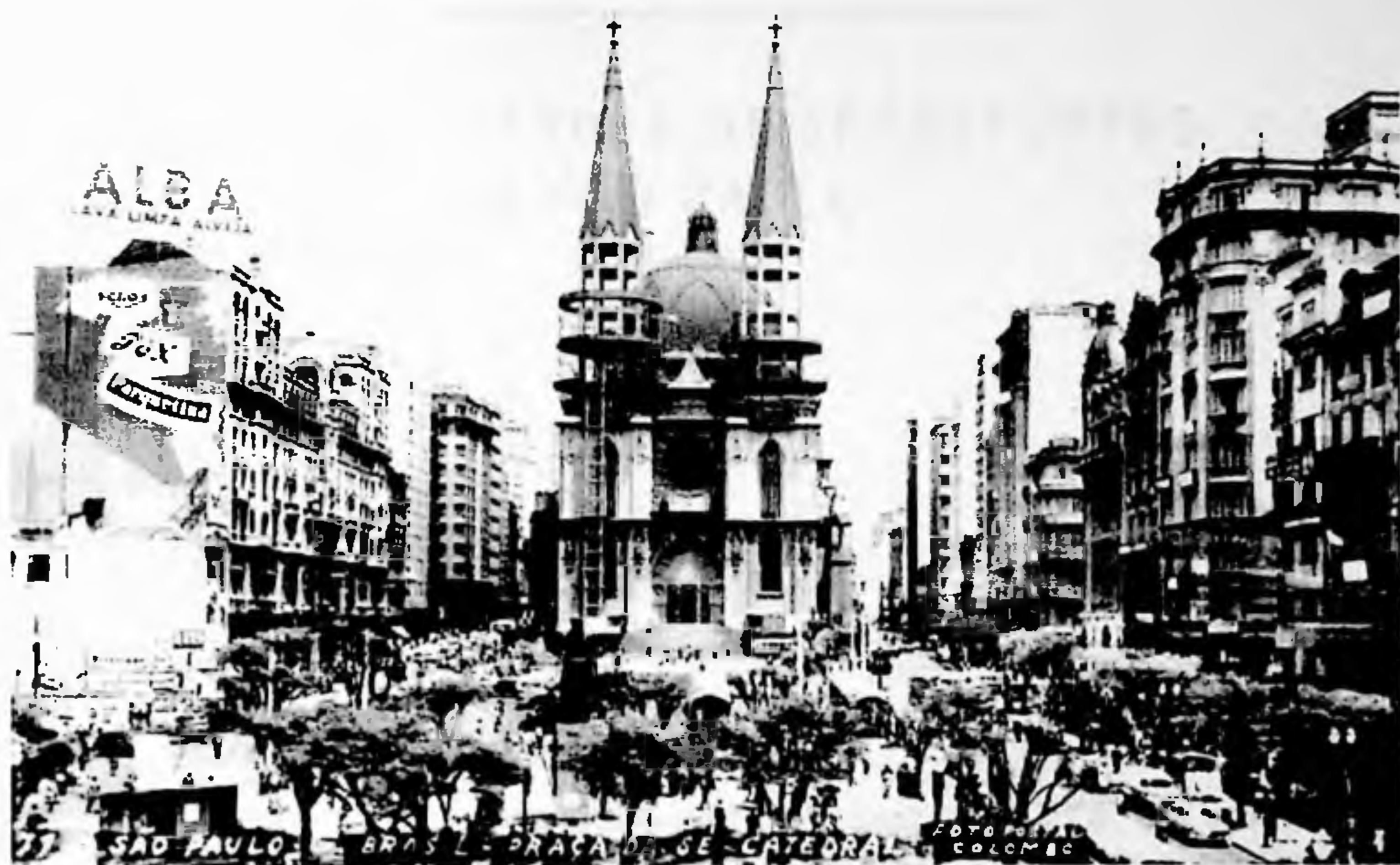
Fig 52 – Praça da Sé em 1960, ainda com a construção das duas torres em andamento.
