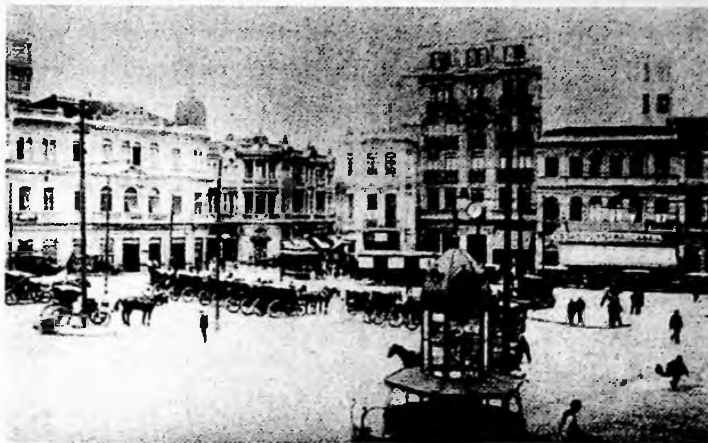
Fig 38 – setor interno da Praça da Sé, onde podemos verificar a existência de mictório público em ferro fundido, ao centro, 1916.
