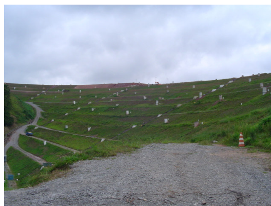
Foto 25 - Vista geral do aterro, com drenos gás em destaque
