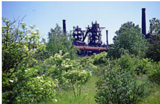
Foto 43 - Área com vegetação, de acesso restrito
