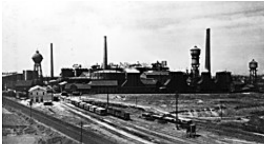
Foto 41 - Vista das instalações da antiga siderúrgica Thyssen
