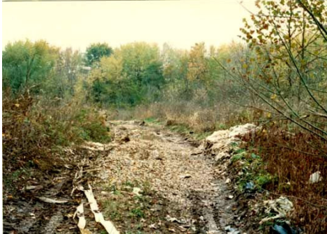
Foto 49 - Vista do aterro, antes da recuperação
