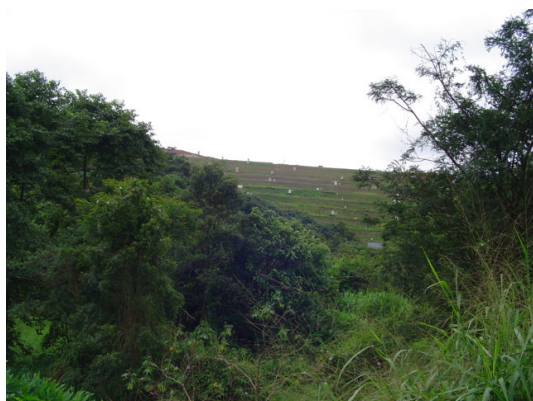
Foto 24 - Vista do aterro ao fundo, com mata remanescente em primeiro plano
