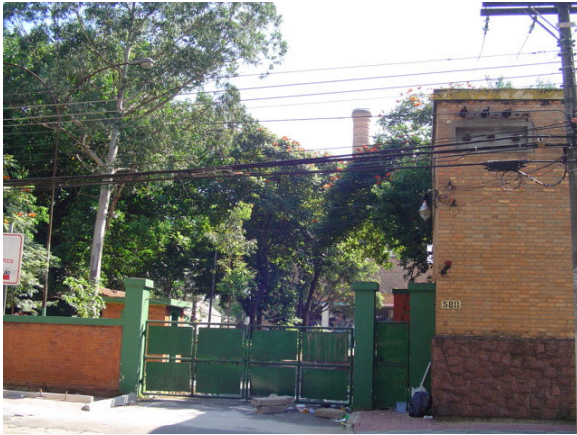
Foto 81 - Vista frontal da área do incinerador
