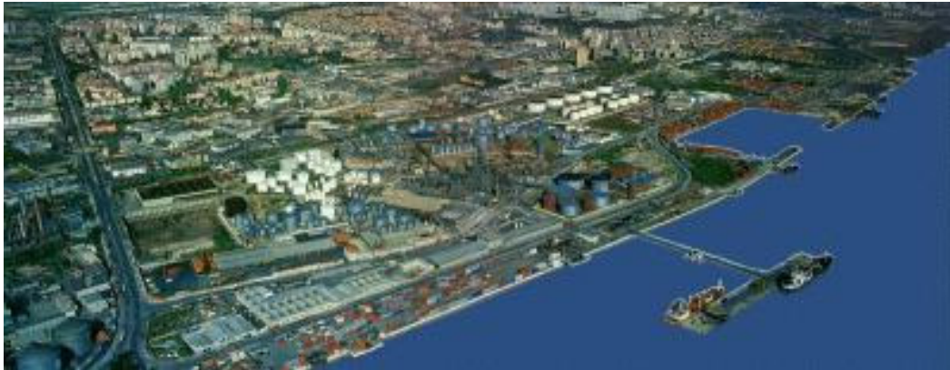
Foto 47 - Vista da área do Parque das Nações antes da intervenção, com as empresas petrolíferas ao centro
