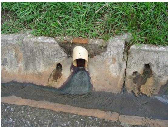
Foto 16 - Trecho do sistema de drenagem superficial, mostrando saída de líquido percolado
