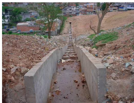
Foto 21 - Escada hidráulica em construção
