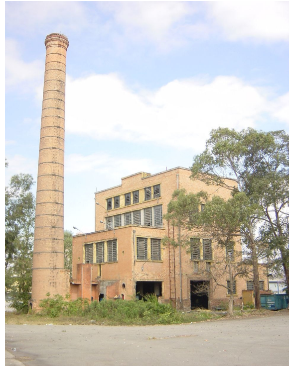
Foto 78 - Edificação do antigo incinerador
