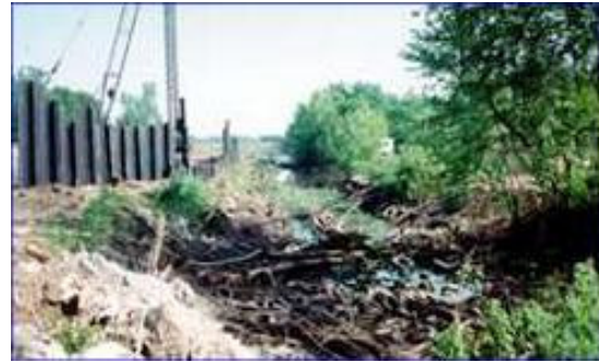
Foto 52 - Vista do aterro, antes da recuperação
