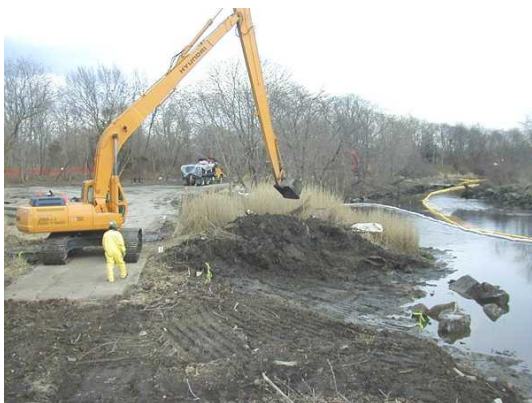
Foto 65 - Processo de dragagem de sedimentos contaminados com PCBs do leito do rio
