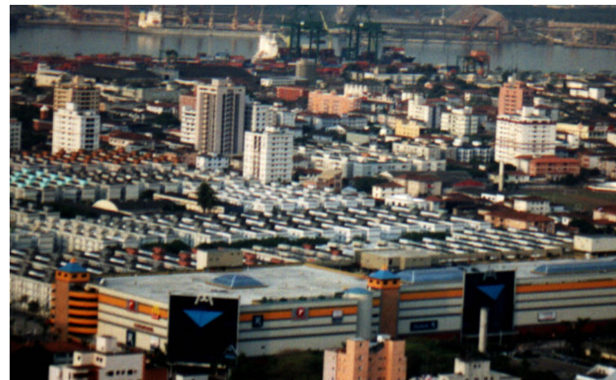
Figura 45 - Vista aérea do Shopping Praiamar, em segundo plano o conjunto habitacional BNH da Aparecida, Santos.
