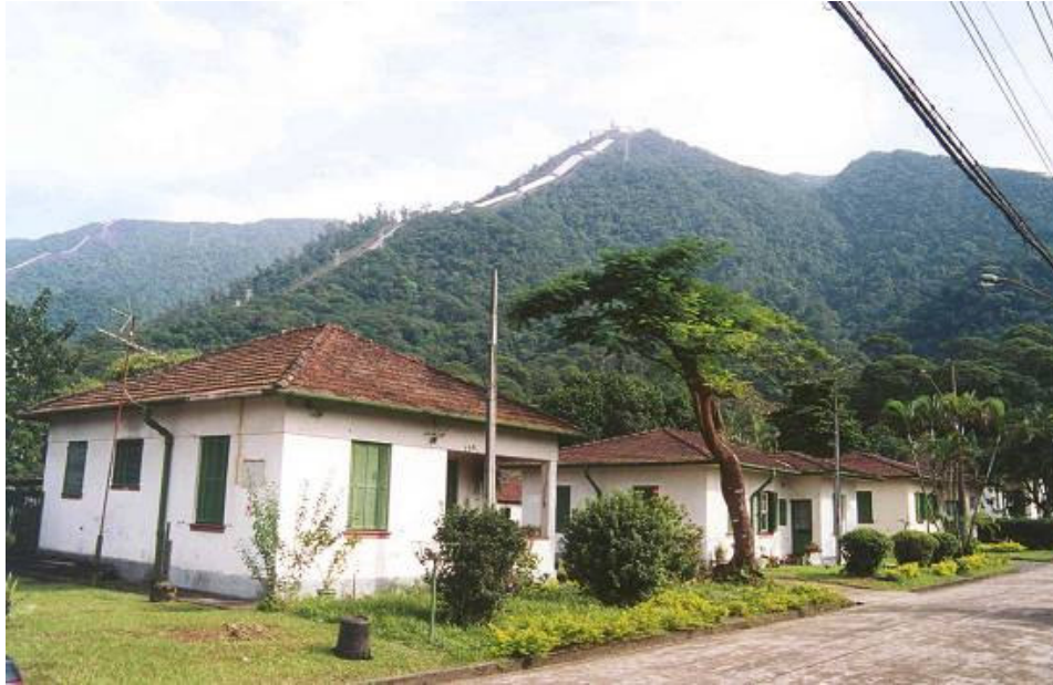
Figura 6: Casa de engenheiro situada na Rua Paraná na Light. Fonte: < http://www.novomilenio.inf.br/cubatao/ > Acesso: 26 abr. 2006
