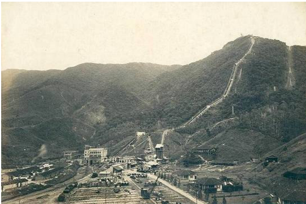
Figura 5: Instalação da Usina Henry Borden. Ao fundo observamos a escarpa da Serra do Mar com as tubulações descendo até a Usina Externa (construção alta à esquerda). Do lado direito vemos três casas de funcionários.
