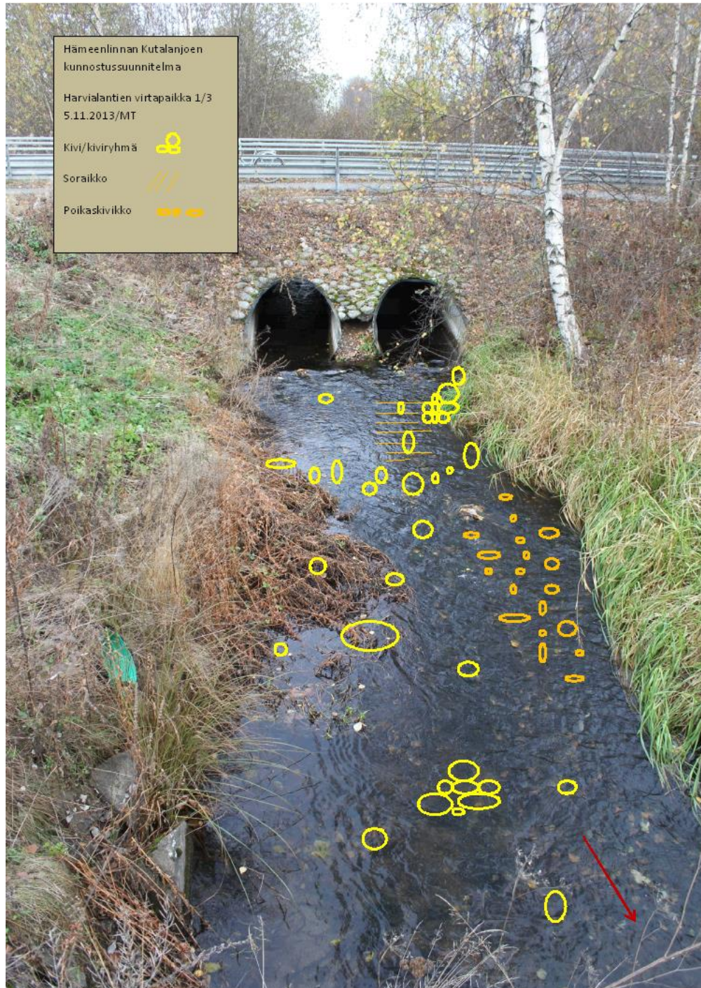
Kuva 16. Harvialantien kevyen liikenteen väylän alapuolelle suunnitellut kunnostustoimenpiteet.
