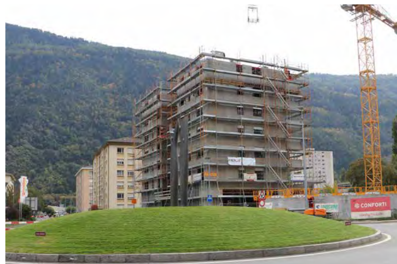
Immeuble Les Avouillons, à Martigny.
