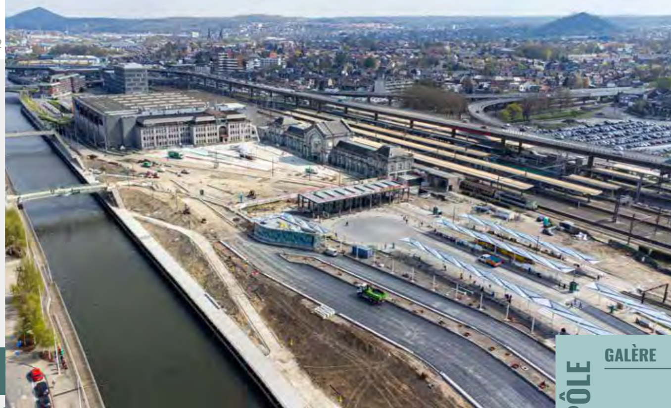
À Charleroi, l'aménagement des quais doit améliorer la traversée de la Sambre dans la ville basse et dans le quartier de la gare de Charleroi Sud.
