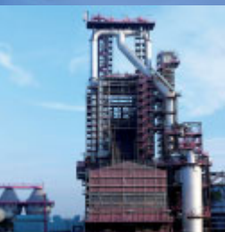
„Wind auf“ Hochofen 8 in Betrieb
