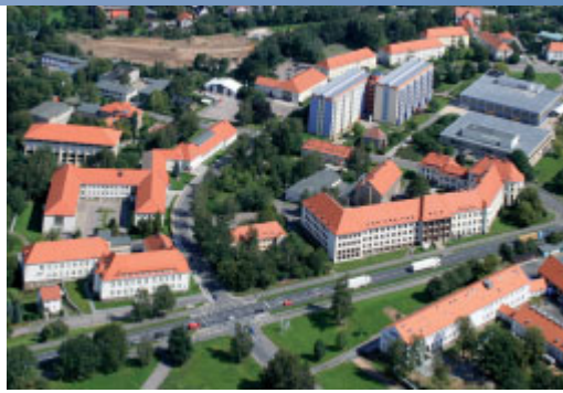
▲ Bei ihrer Gründung 1765 war die TU Bergakademie auf Bergbau spezialisiert. Zu den Kernkompetenzen der Freiburger gehören heute gerade auch Schlüsseldisziplinen rund um den Einsatz von Stahl im Autobau.
