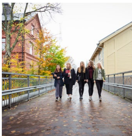
Gång- och cykelbro över till Vulcanön.
