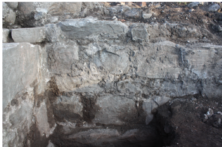
Figur 3. Del av stenhusets inre nordvägg, som är uppbyggd med kvaderstenar, dvs. tillhuggna byggnadsstenar, vilket var en exklusiv byggnadsteknik och pekar på att byggnaden har uppförts under 1100-talet eller 1200-talet. Murarna är uppförda av granit och gnejs, och samma byggnadsmaterial ingår enligt en preliminär bedömning i den romanska kyrkobyggnaden. Foto: Anders Ohlsson.
