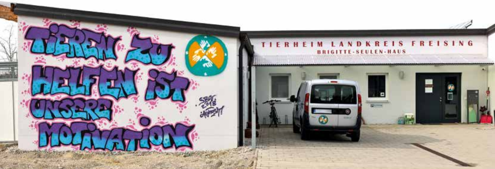
2018 wurde das erste Tierheim im Landkreis Freising fertiggestellt. Es gibt noch viel zu tun.
