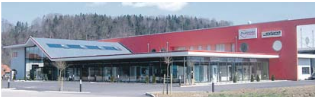
Eine große Auswahl an Badeeinrichtungen - wo mit Sicherheit für jeden das Richtige dabei ist - bietet Weyland in Regau
