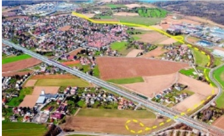
In einer ersten Etappe (durchgezogene Linie) soll der Südpark ans Straßennetz angebunden werden. Die zweite Etappe (strichlierte Linie) sieht eine Weiterführung der Linie 2 bis zum Bahnhof Pichling vor. Foto: Stadtplanung Linz/Perlthieser
