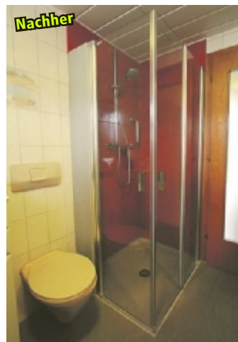
Geschlossene, barrierefreie, rutschfeste Dusche, fugenlos, Design-Vinylclickboden in Schieferoptik.
