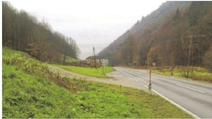
Hier soll die neue Park-and-Ride-Anlage entstehen.
