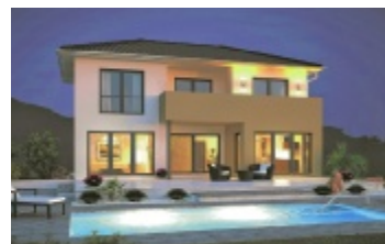
Ein „Energy“-Haus von Hanlo
