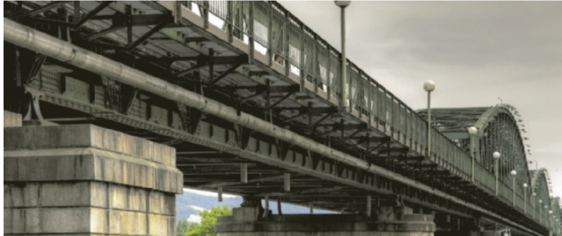
Quo vadis, Eisenbahnbrücke? Nach der Aufhebung des Denkmalschutzes dauern Diskussionen um Zukunft an. Foto: vowe
