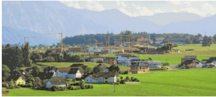
Auf der schönen Sonnenwiese in Gampern wurde und wird fleißig gebaut.
