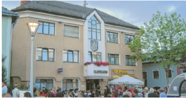
Das Rathaus wird ab 2015 umgebaut und dabei mehr Platz für die Musik geschaffen.
