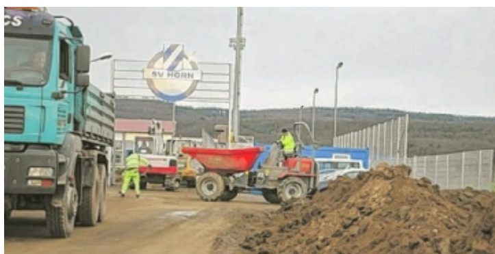
Baustelle am Sportplatz: der SV Horn verbessert die Infrastruktur.
