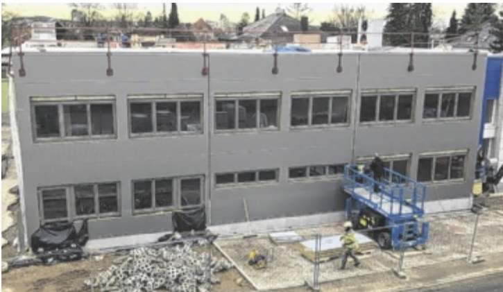
Die Bauarbeiten sollen im Sommer beendet sein.
