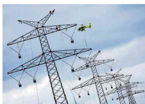
Arbeit hoch oben: Ein Hubschrauber bringt Seile von Mast zu Mast.
