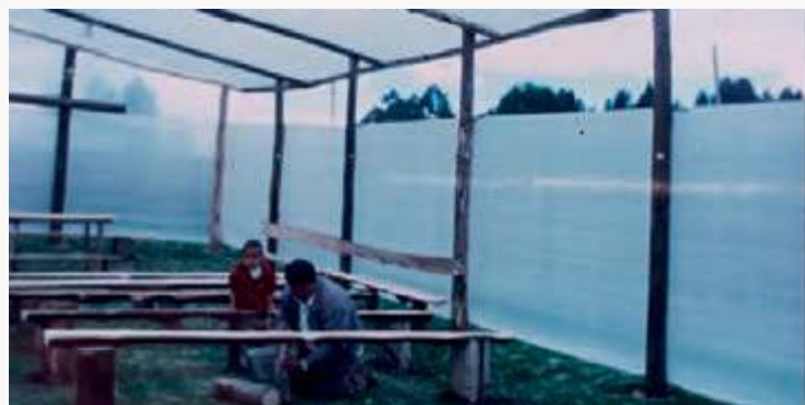
Figura 309: Capilla construida en plástico y troncos de árboles (Foto del año 2000 aprox)
