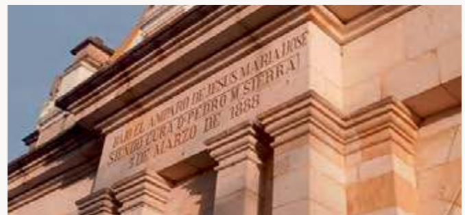
Figura 367: Fachada Iglesia Santiago Apóstol
