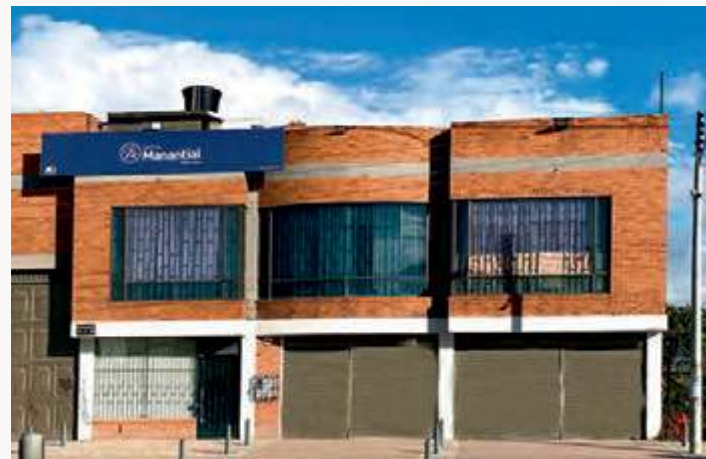
Figura 237: Fachada Iglesia Manantial de Vida Eterna.
