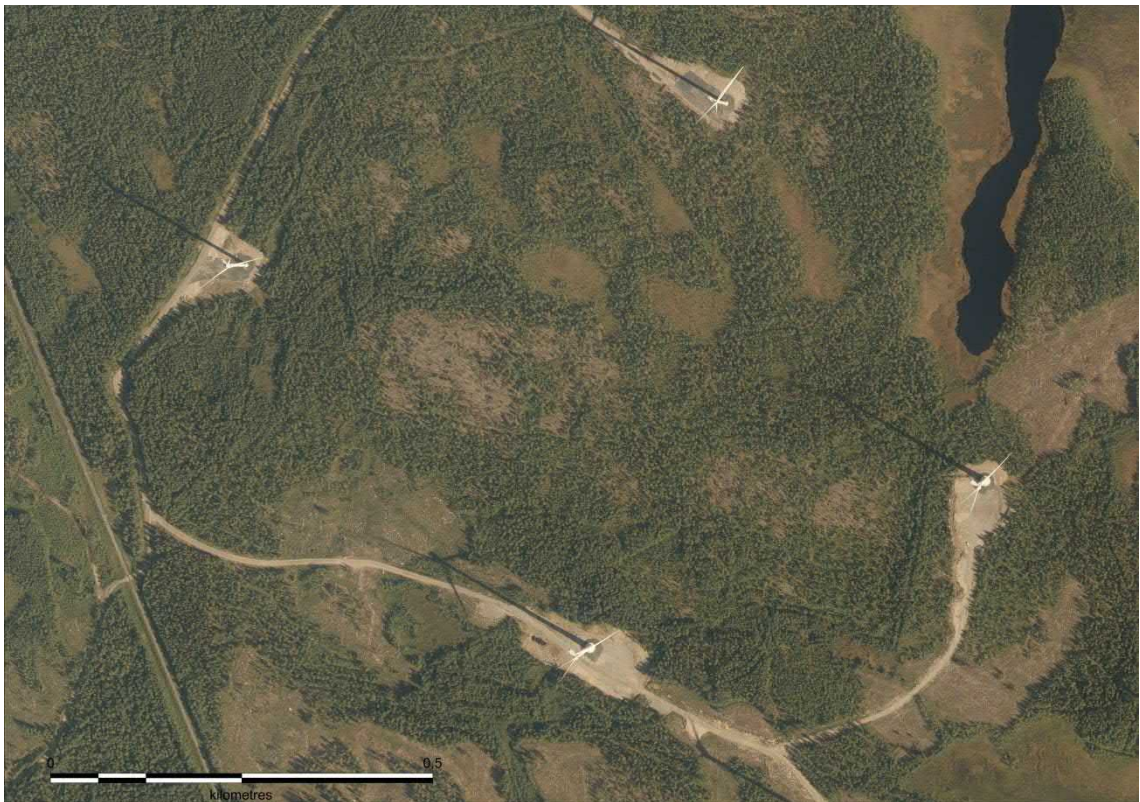
Kuva 2.8. Ilmakuvassa näkyy toiminnassa olevia tuulivoimaloita. Tuulivoimaloita varten on rakennettu huoltotiet ja nostokentät. Tuulivoimaloiden ympäristössä ja välialueilla aikaisempi maankäyttö on säilynyt ennallaan.
