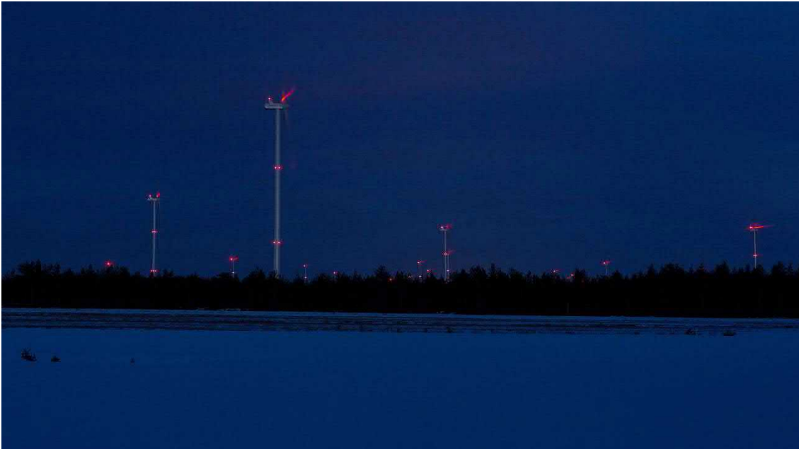
Kuva 2.11. Kiinteät punaiset lentoestevalot. (Kuva: Ville Suorsa, FCG)
