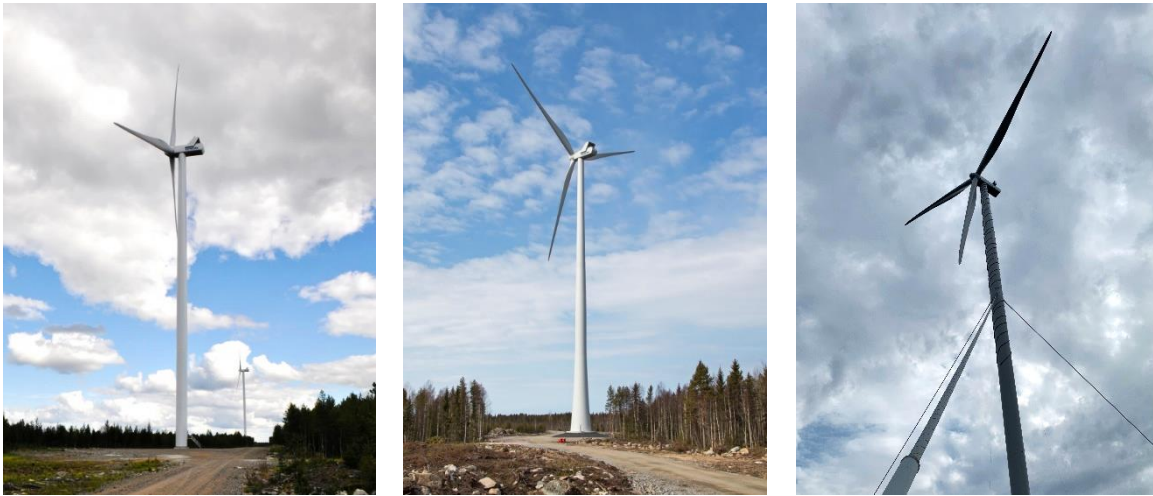
Kuva 11. Vasemmalla on esimerkki teräslieriötornista, keskellä hybriditornista ja oikealla harustetusta tornista. (Kuvat: FCG sekä Jarkko Finnilä, Carelin)
