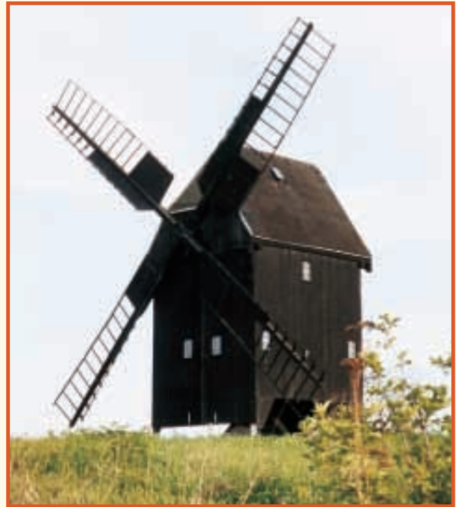
Bockwindmühle auf dem Liebschützberg
