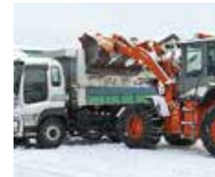
▲雪を重機で取り除き、トラックで運び出す様子
