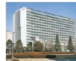
本社テクニカルセンター
