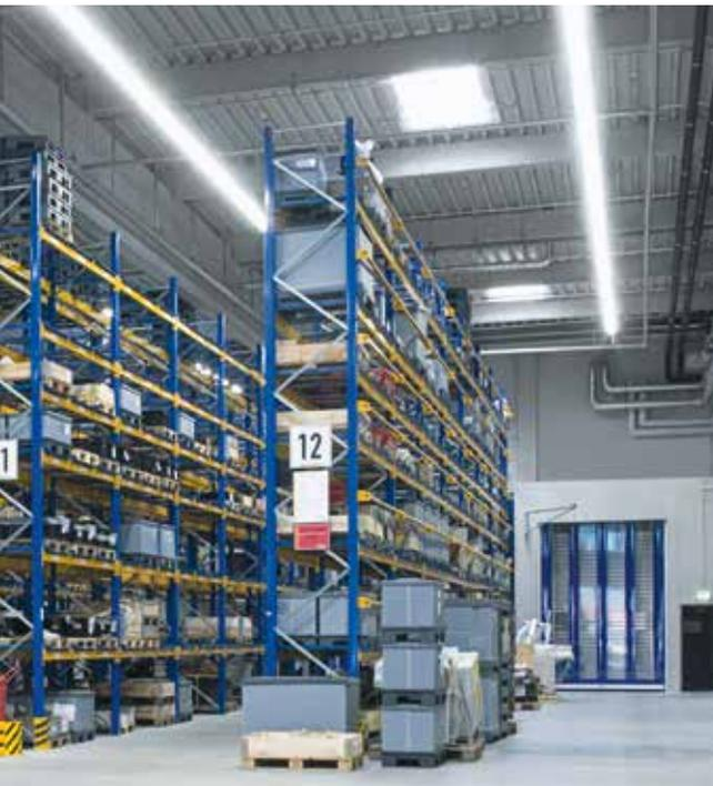
Die E-Line LED ist die optimale Lösung für herkömmliche Beleuchtungsanlagen in der Industrie. Sie punktet mit beeindruckender Effizienz bei hoher Lichtausbeute und ist mit wenigen Handgriffen auf vorhandene TRILUX Tragschienen montiert. Daher ist sie die ideale Lösung für die Lichtsanierung.
