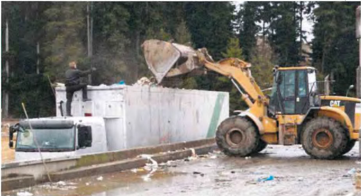
Radlader an der bestehenden Umladestation Lkr. Tuttlingen
