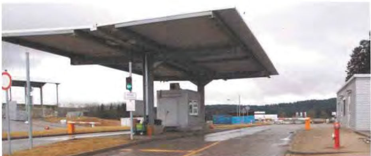
Wägeeinrichtung an der Deponie Talheim (rechter Bildrand Sozialeinrichtungen).
