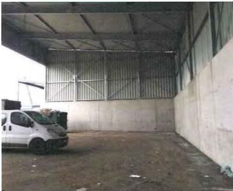
Stahlbetonwände mit aufgesetzter Stahlhalle und flüssigkeitsdichtem Asphaltboden (Notfall-Umladestation im MHKW-Weißenhorn)
