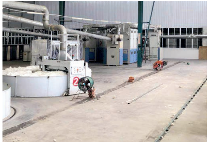
BO-P wird in Hunan Huayi installiert, wo die Putzereinlinie modifiziert werden muss; die Anlage verläuft an der Wand
