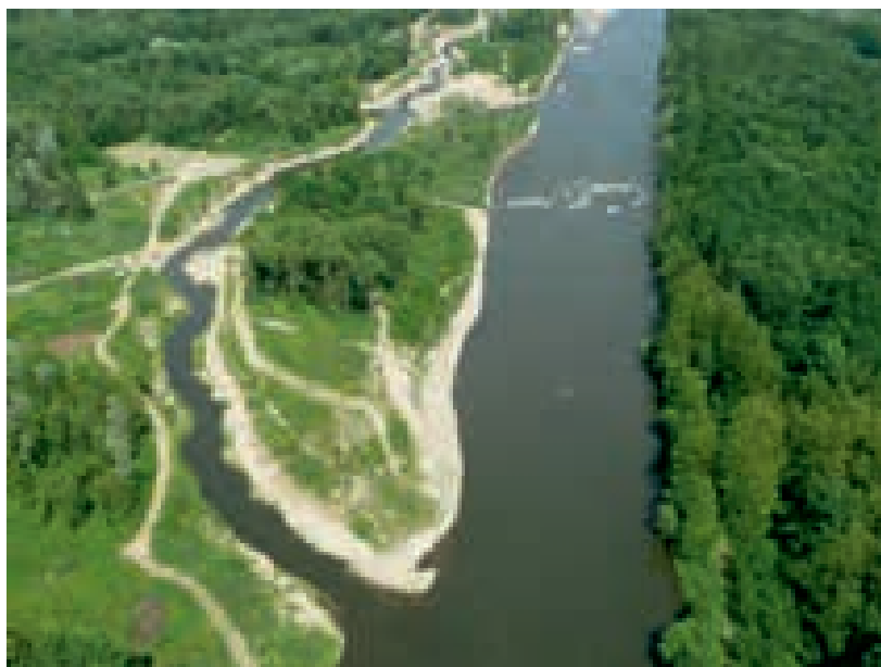
Abb. 5. a) Luftaufnahme der Aufweitungsstrecke nach Vollendung der Baumaßnahmen (Foto: J. Pfeiler, Mai 2008).
