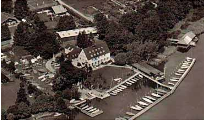
DTYC-Gebäude in Tutzing: Renomme in der Segelwelt
