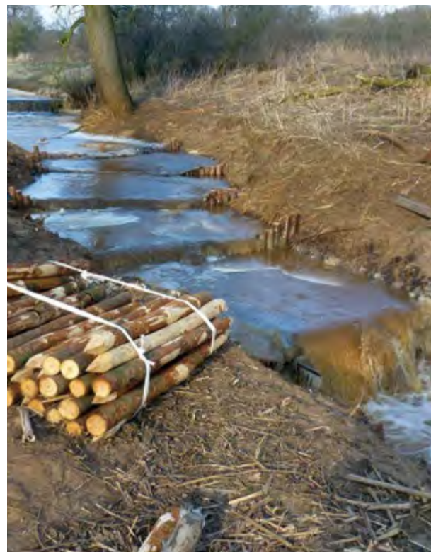
Abschnitt des Hakengrabens während der Maßnahmen- durchführung
