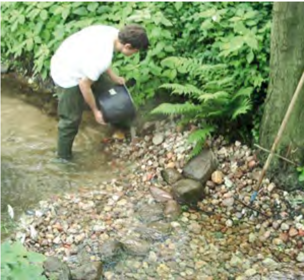
Strömungslenker und Kiesbetten wurden eingebaut
