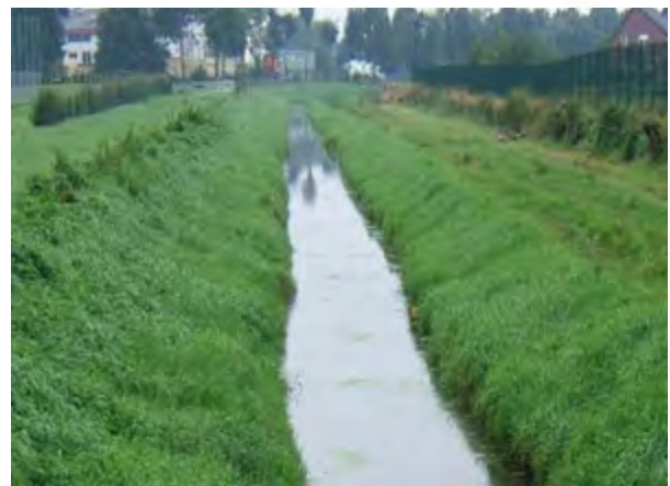
Hopener Mühlenbach vor der Maßnahme
