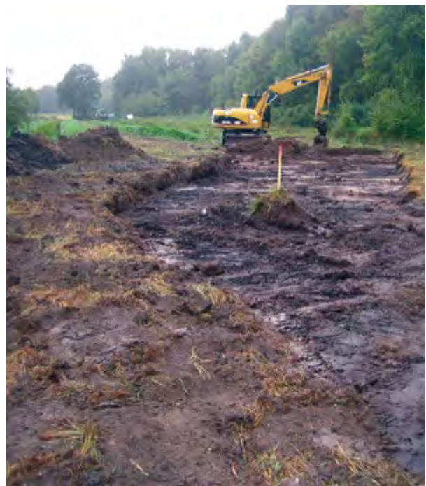
Anlage einer Sekundäraue
