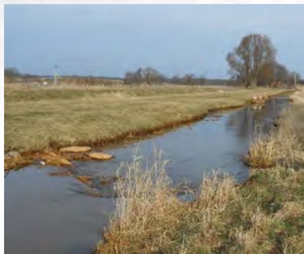
... und nach dem Einbau der Buhnen
