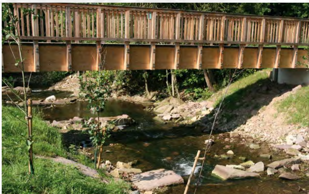
Fußgängerbrücke über die Lenne
