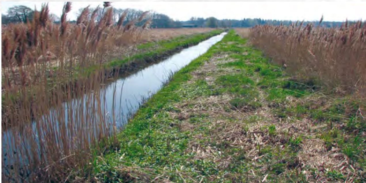
Alter Lauf der Esterau - Vor der Umgestaltung grabenartig ausgebaut
