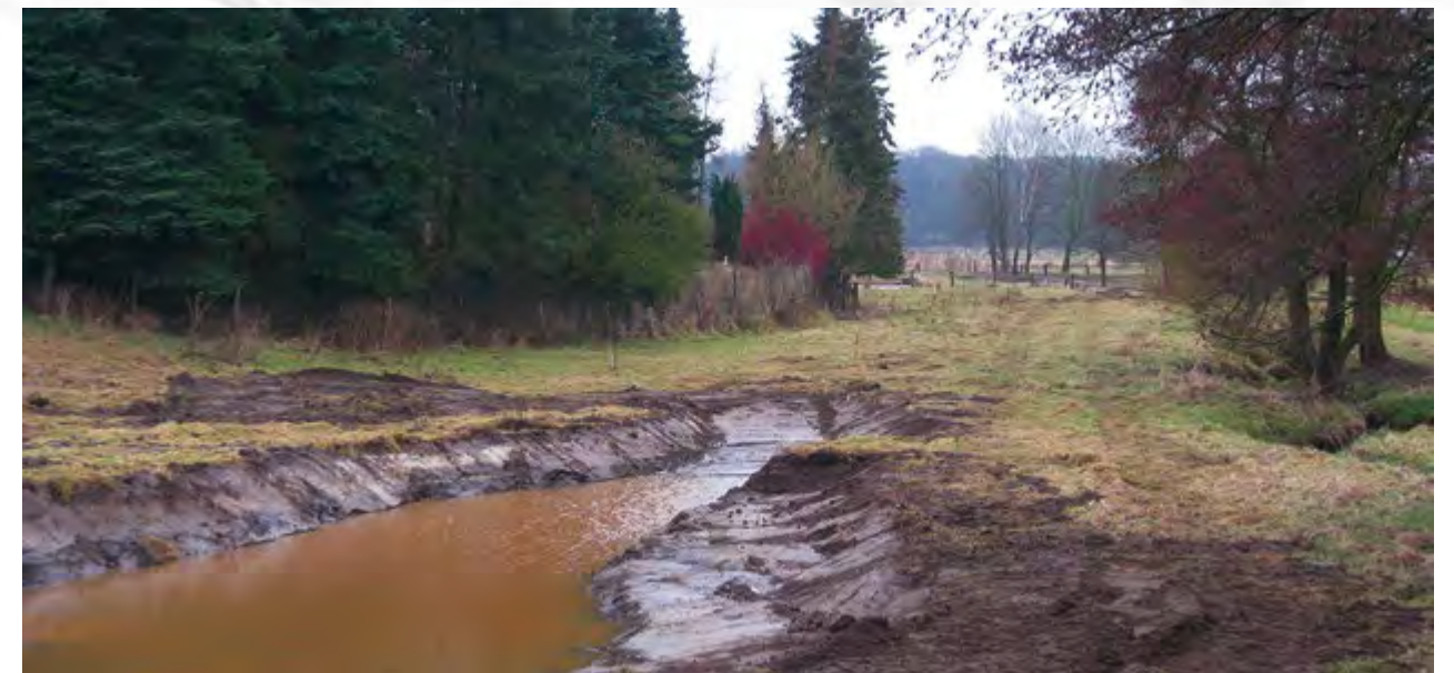
Während der Umsetzung der Maßnahmen
