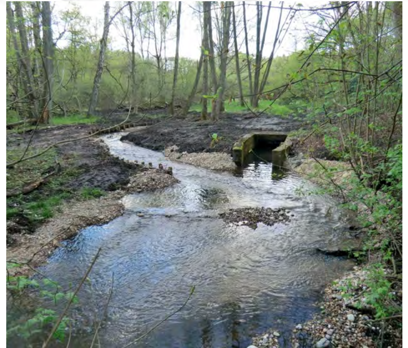
Geschwungenes Gerinne bei der ehemaligen Wehranlage 3
