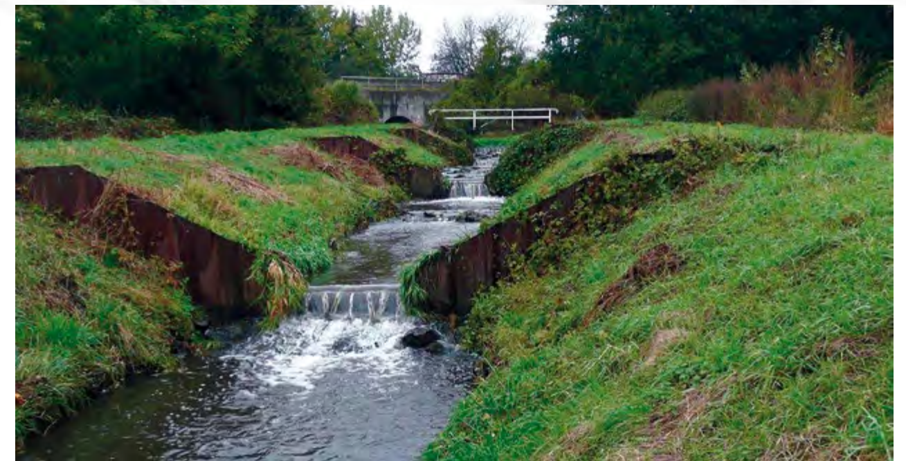
Scharmbecker Bach: Ausgangssituation 2011
