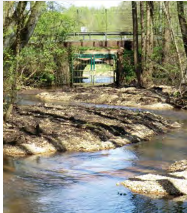
Umgestaltung unterhalb des ehemaligen Wehres mit Blick gegen die Fließrichtung
