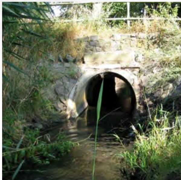
Einlauf in die Verrohrung nach der Umsetzung
