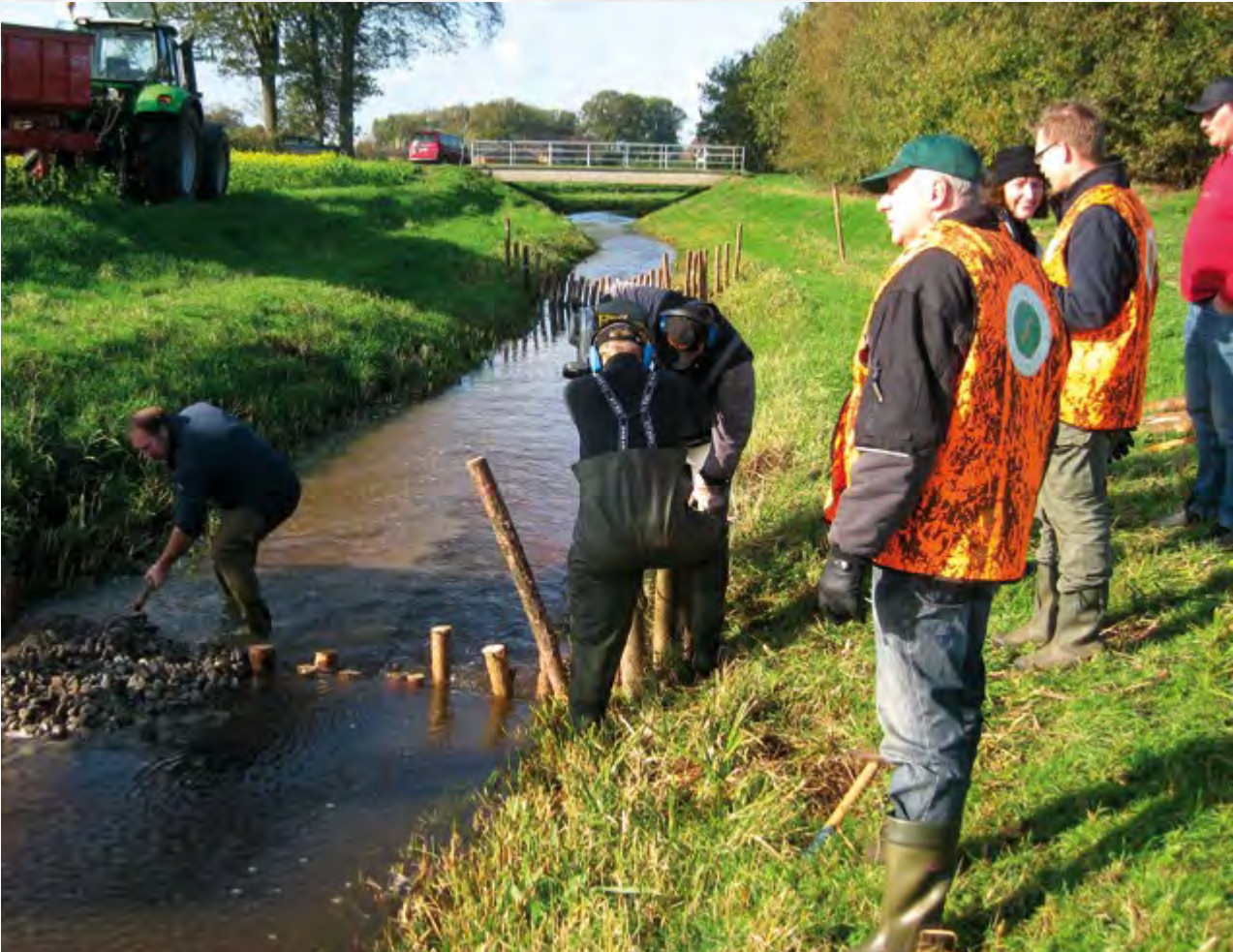
Einbau von Kiesbänken
