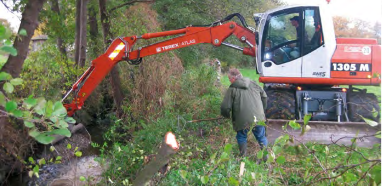
Maschinelle Einbringung von Kies in das Gewässer
