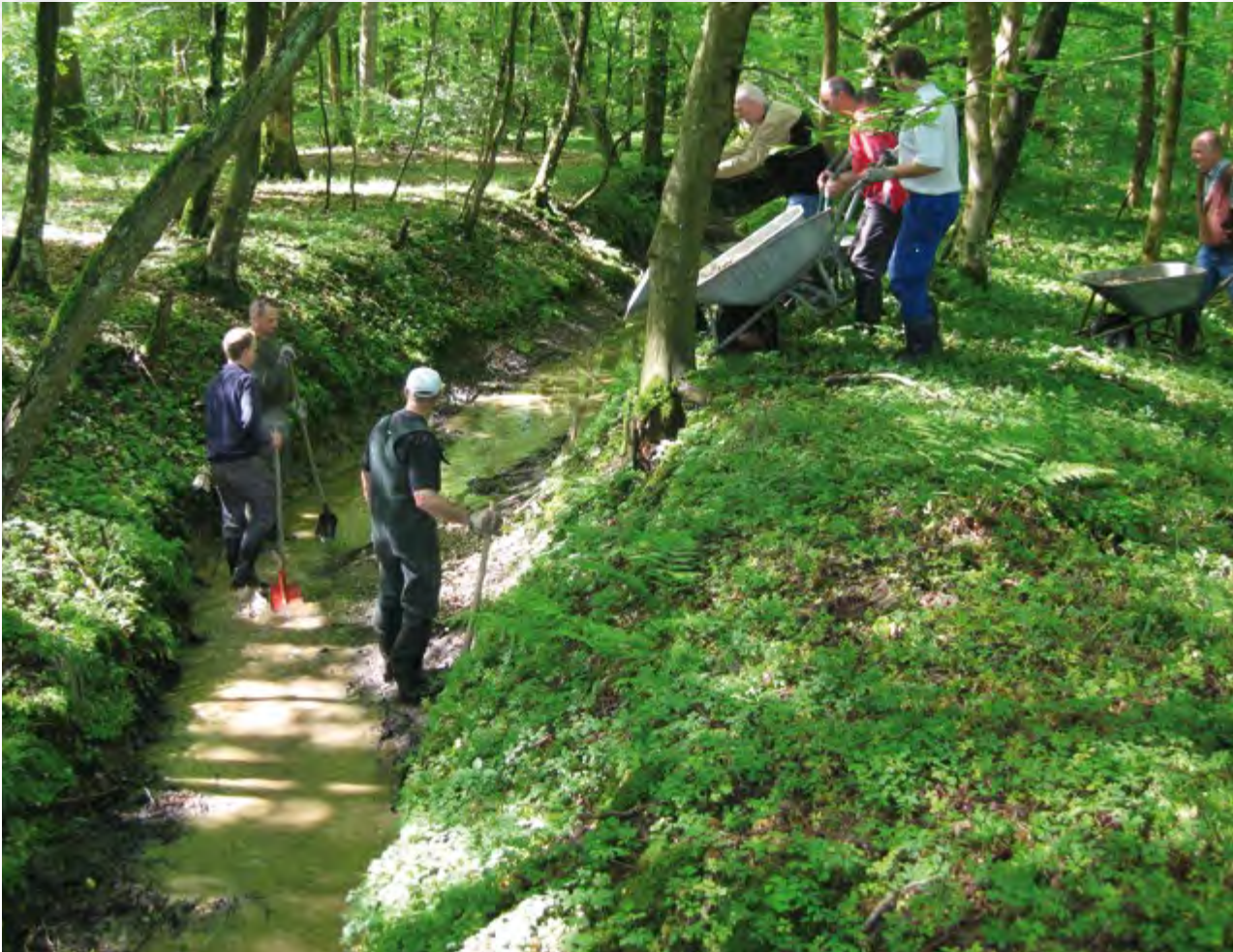
Kieseinbau im Lohriengraben
