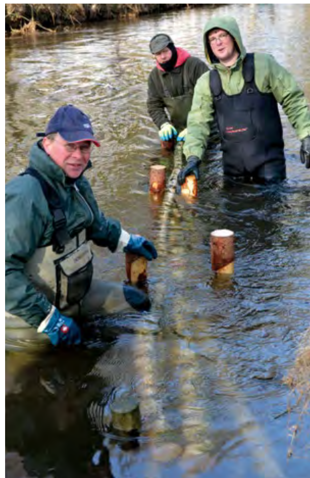
Holzkonstruktion im Aufbau
