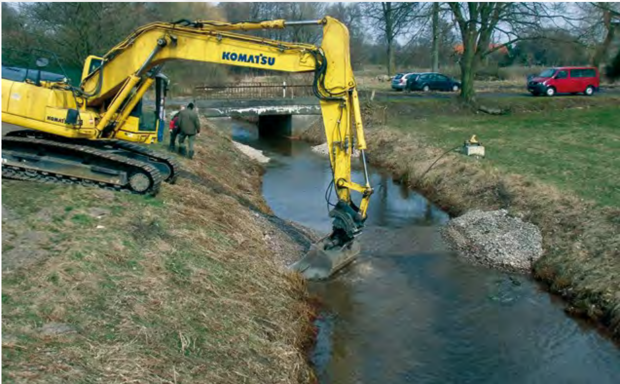
Einbau einer Kiesbank in der Riehe
