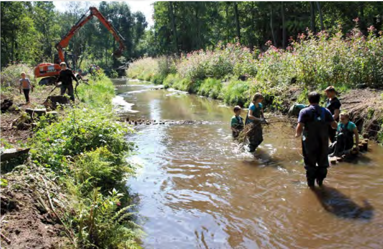
Einbringung von Strömungslenkern ...
