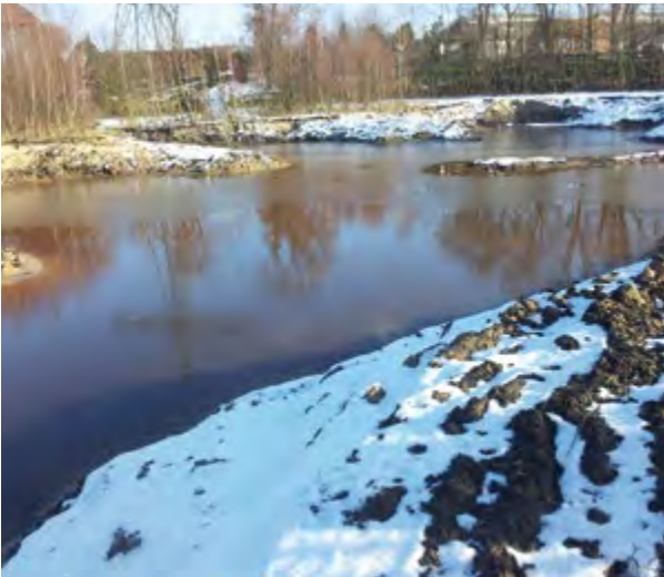
Lathener Beeke nach der Fertigstellung im Januar
