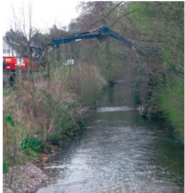
Während der Umbaumaßnahme
