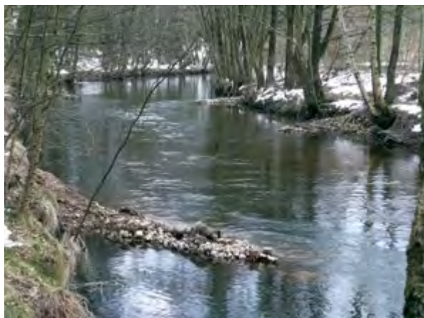
Buhnen nach der Maßnahme
