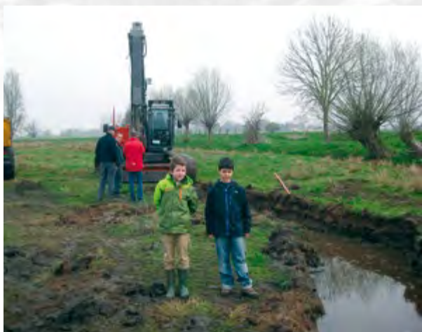
Während der Baumaßnahme ...
