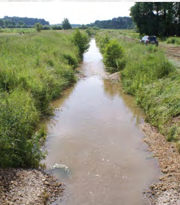
Kurz nach der Maßnahmenumsetzung ...
