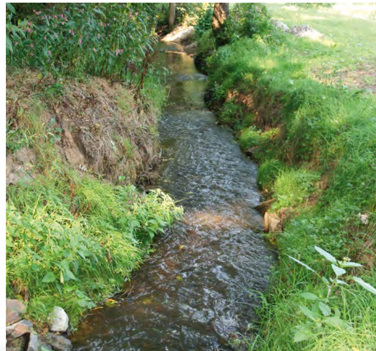
Umgehung des Sandfangs im Hauptstrom im renaturierten Gewässerbett
