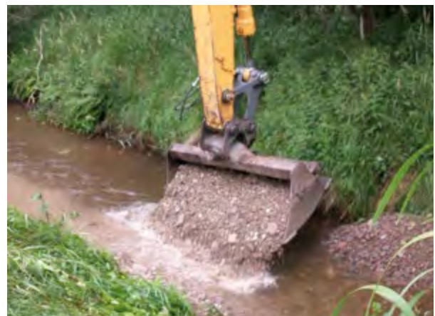
Neuanlage einer Kiesbank
