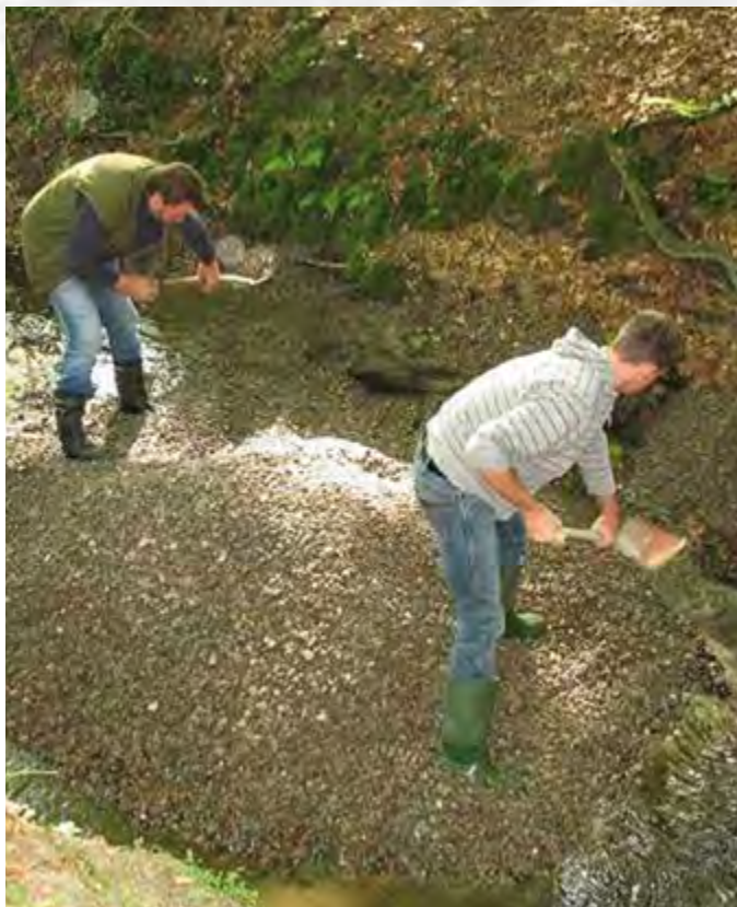
Verteilung von Kies im Gewässerbett
