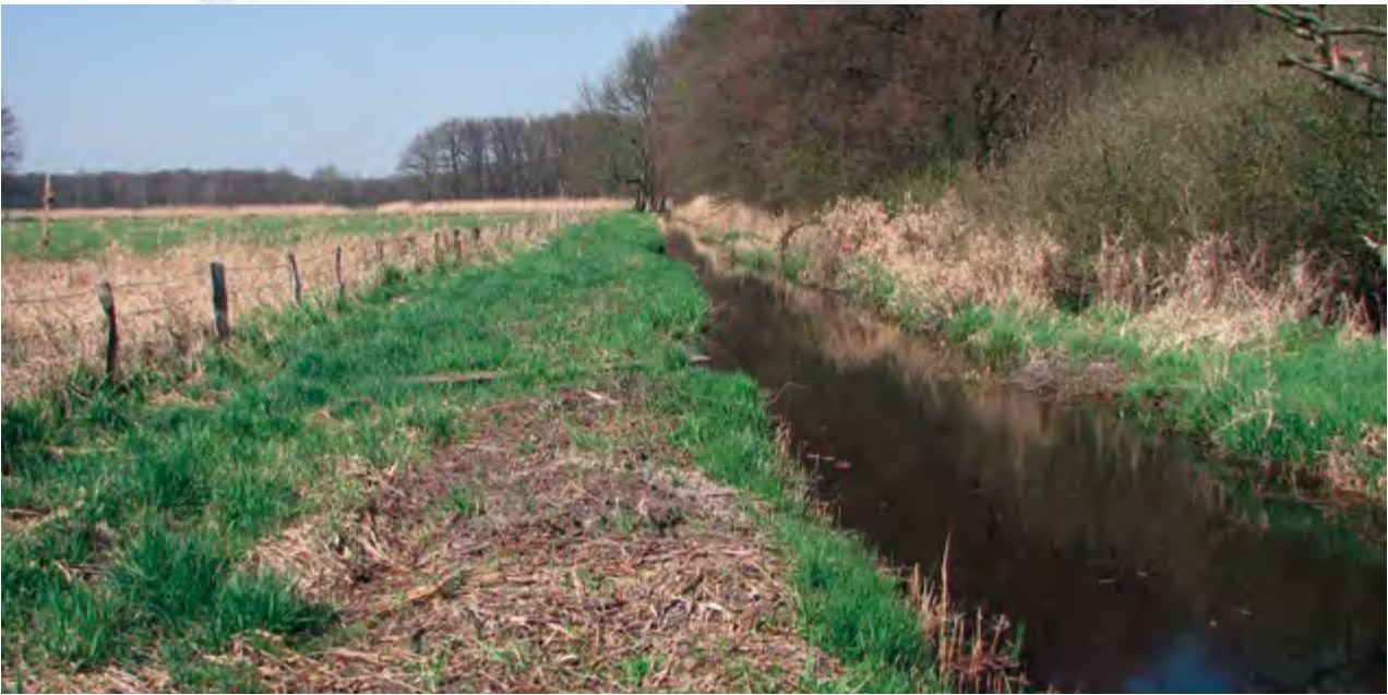
Alter Lauf - Vor der Umgestaltung grabenartig ausgebaut
