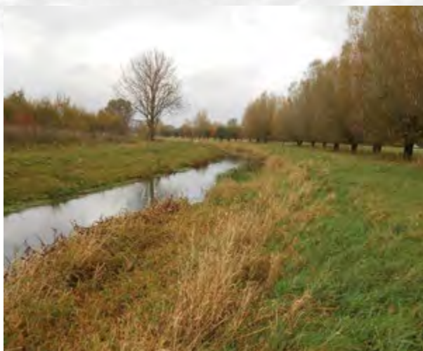
Alte Aue vor Baumaßnahme ...
