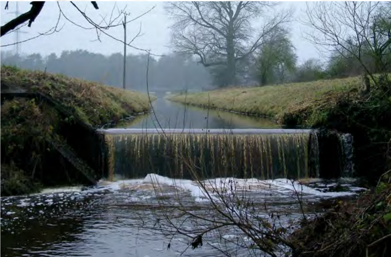
Sohlabsturz bei Hochwasser vorher
