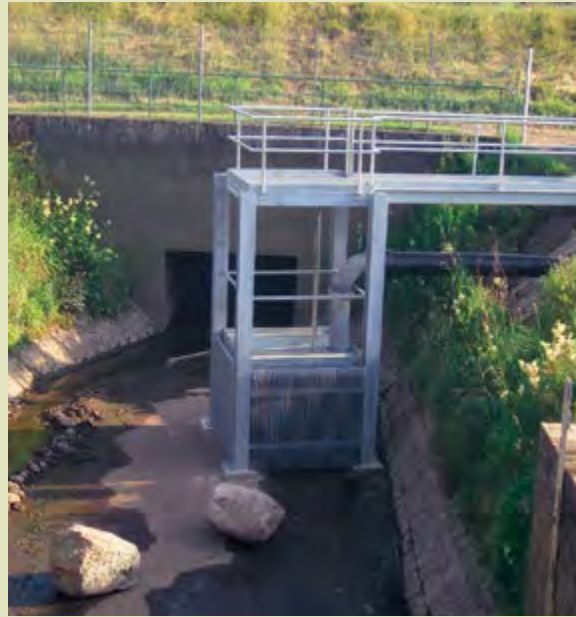
Basbecker Schleusenfleth - Lockstrompumpe
