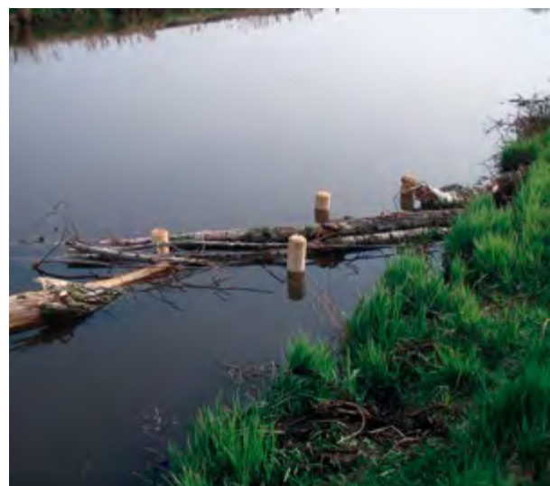
Befestigtes Totholz bei Dreeke
