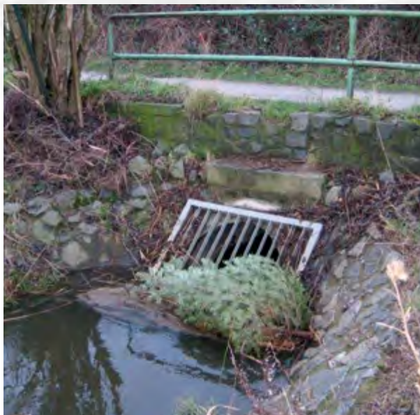
Einlauf in die Verrohrung vor der Maßnahme
