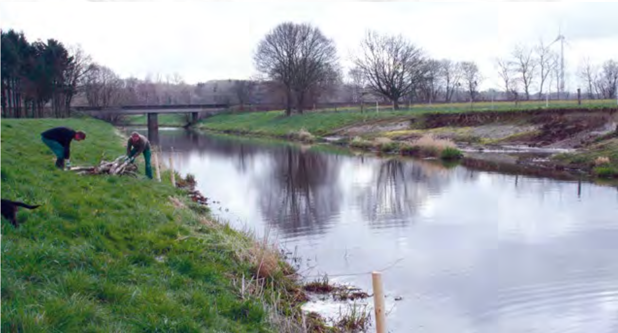
Totholzeinbau bei Cornau
