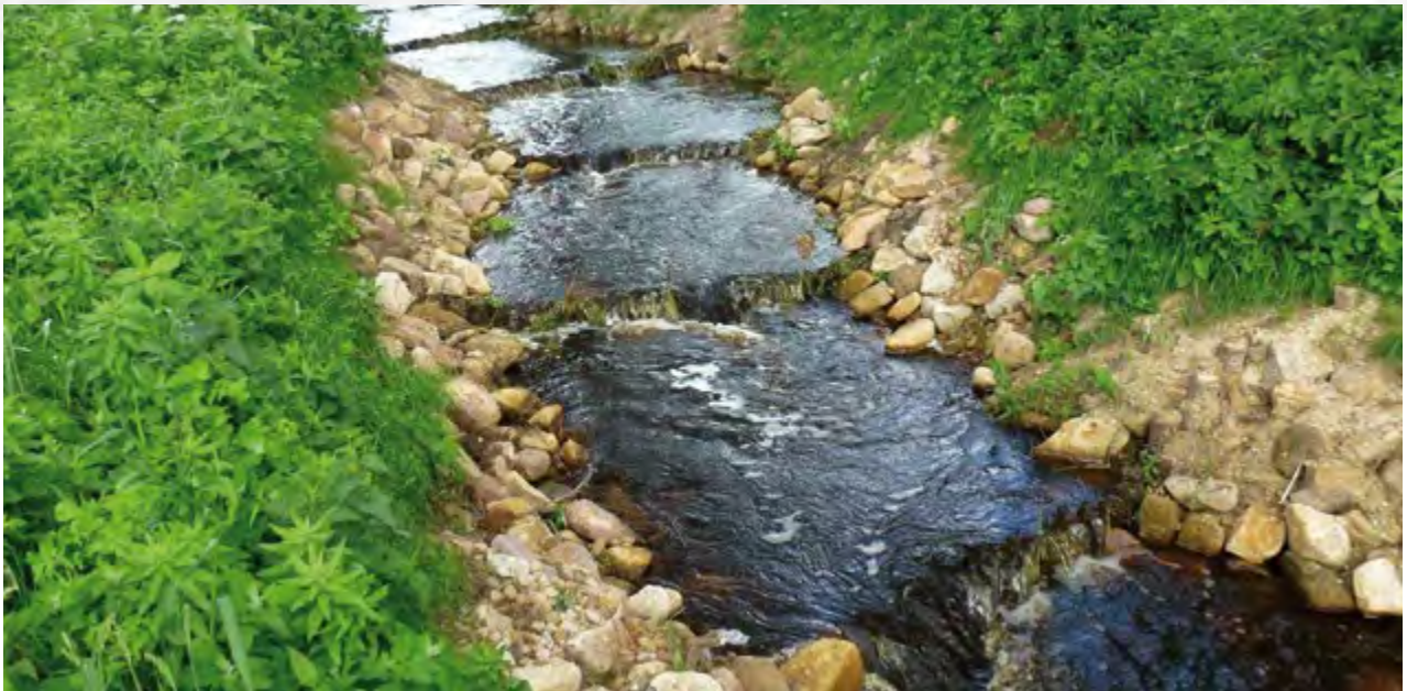
Hakengraben fertig gestellt
