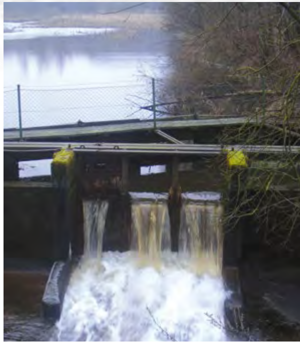
Altes Wehr am Lagerteich bei Beginn der Absenkung
