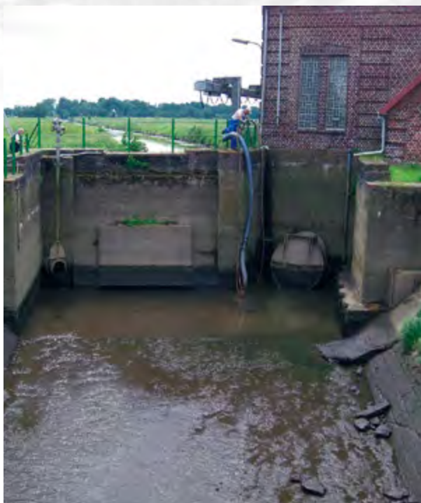
Basbecker Schleusenfleth - Druckkammer vor Maßnahmenbeginn
