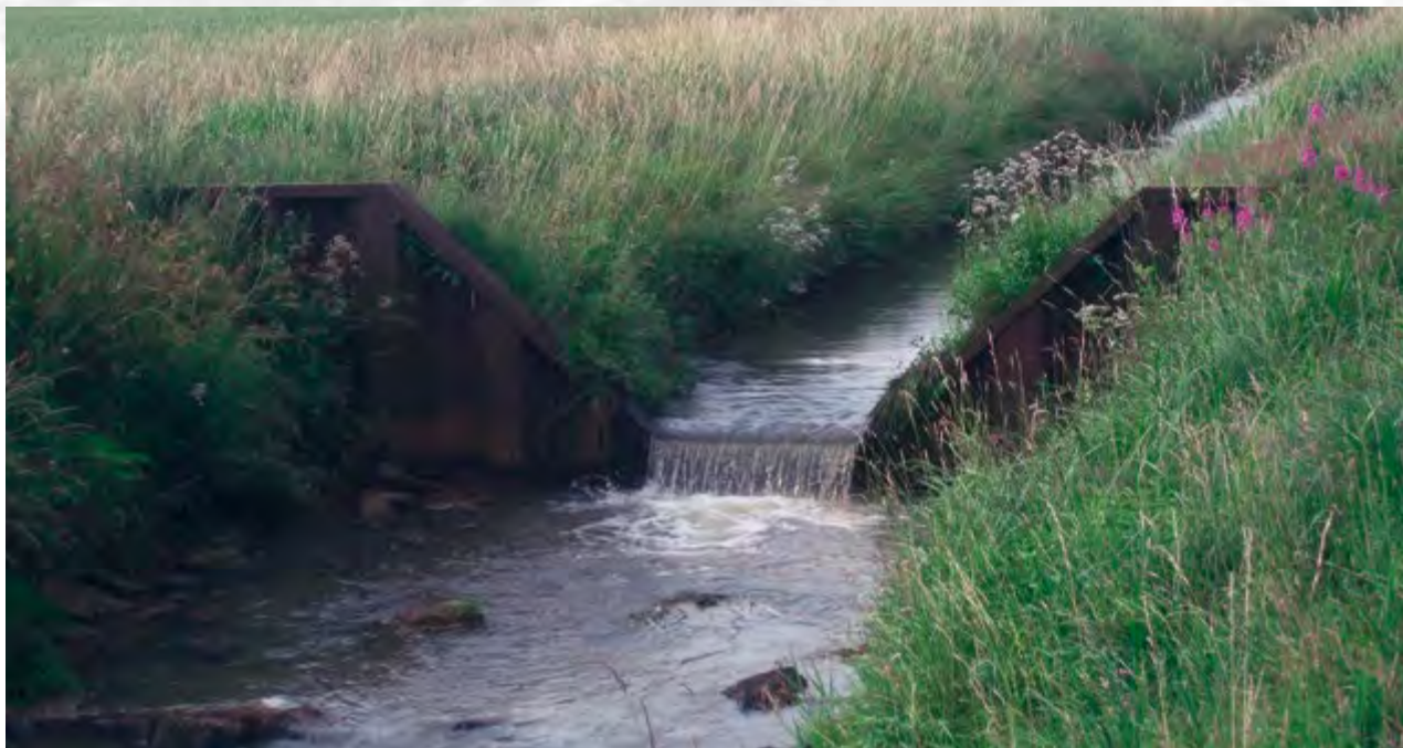
Der ehemalige Sohlabsturz am Dünsener Bach
