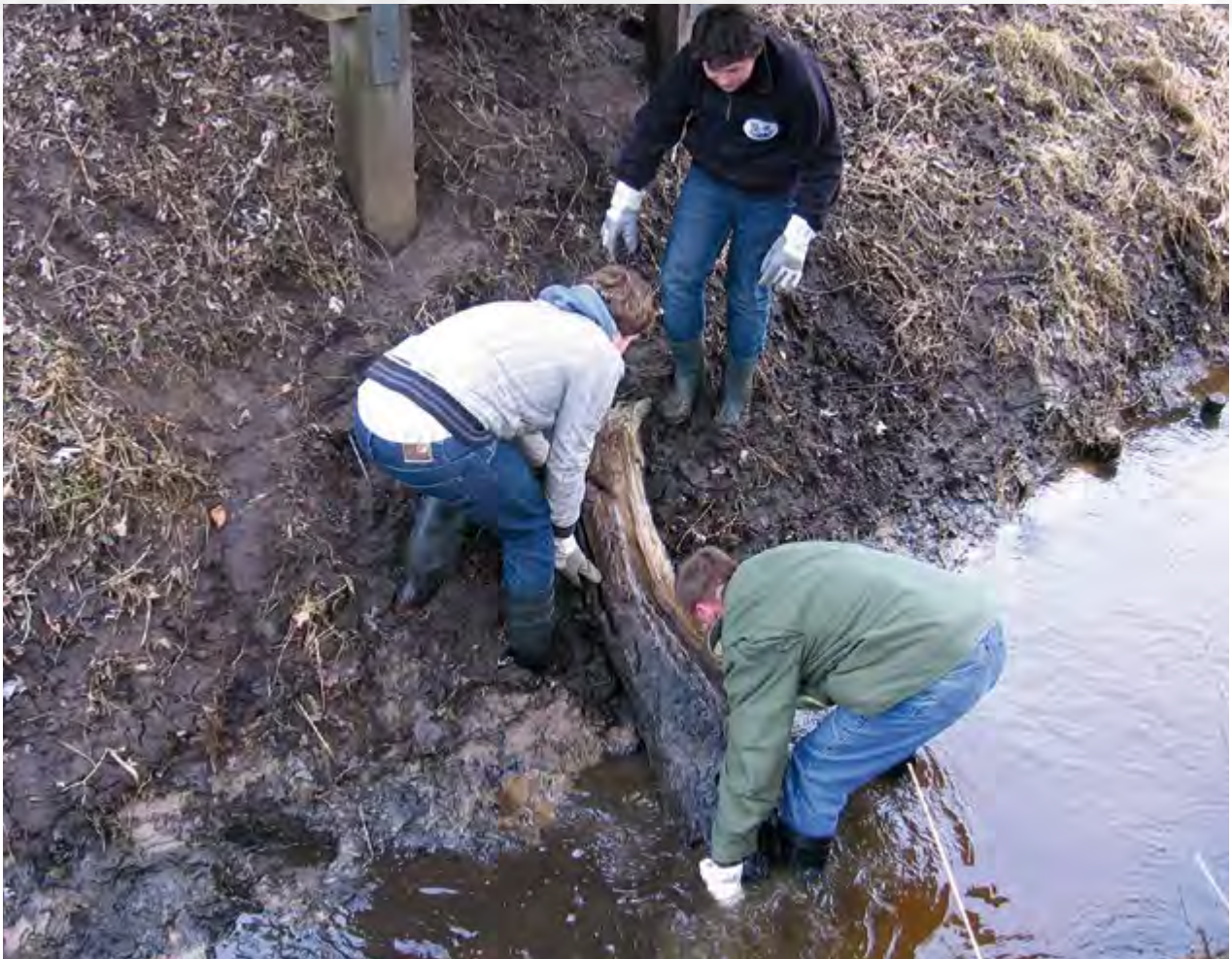
Totholzeinbau in der Böschung
