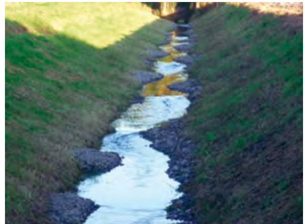
Zustand nach durchgeführter Maßnahme
