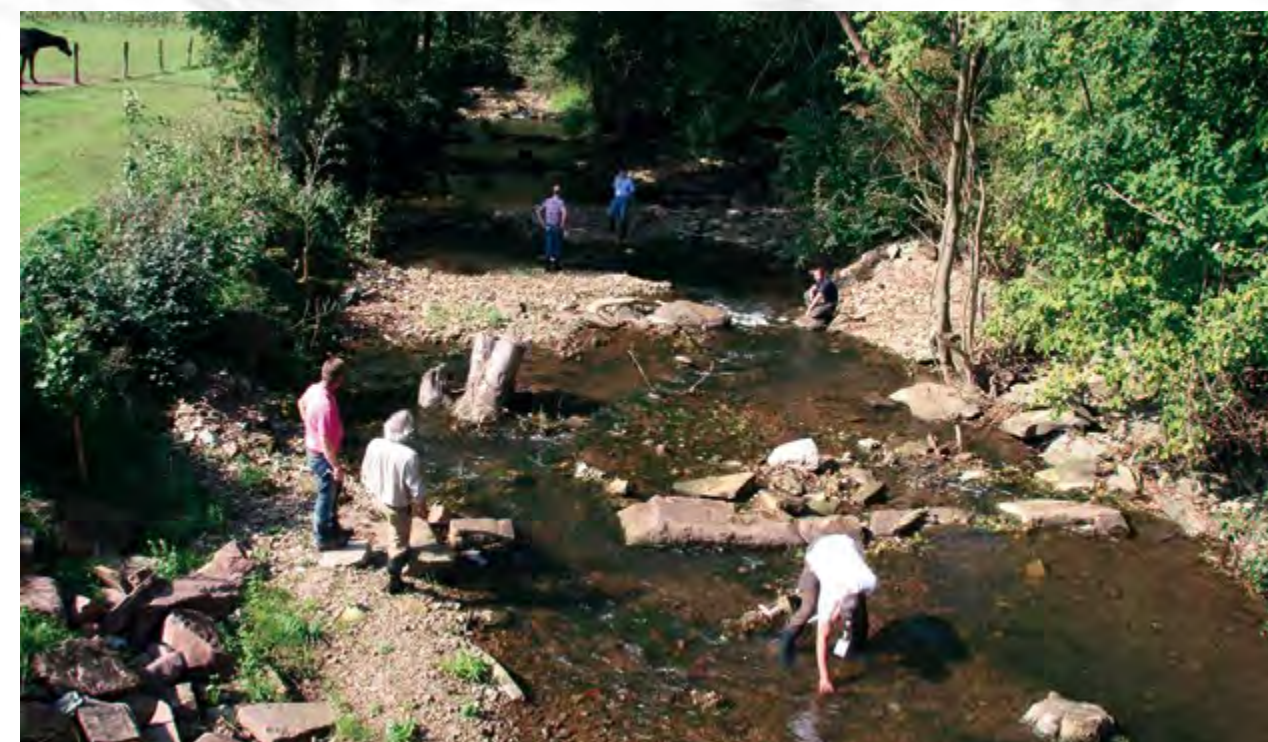
Beeindruckender Rückbau eines Wehres zu einer ökologisch vorbildlichen und zudem landschaftlich ansprechenden Sohlgleite
