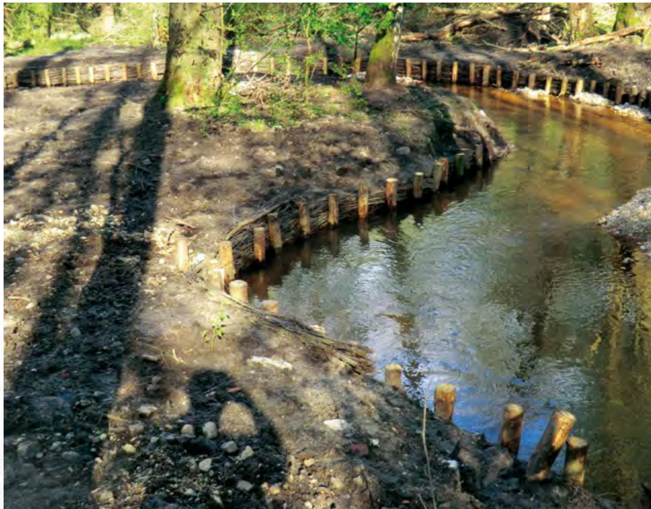
Nach der Umsetzung: temporär gesicherte Prallhänge im neuen Gewässerlauf bei der ehemaligen Wehranlage 2
