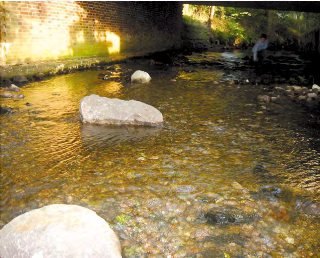
Kiesige Sohlstrukturen nach der Maßnahmenumsetzung
