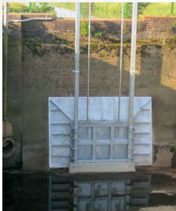
Hubschützanlage
