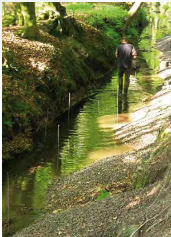
Schaffung eines schmalen Niedrigwasserprofils
