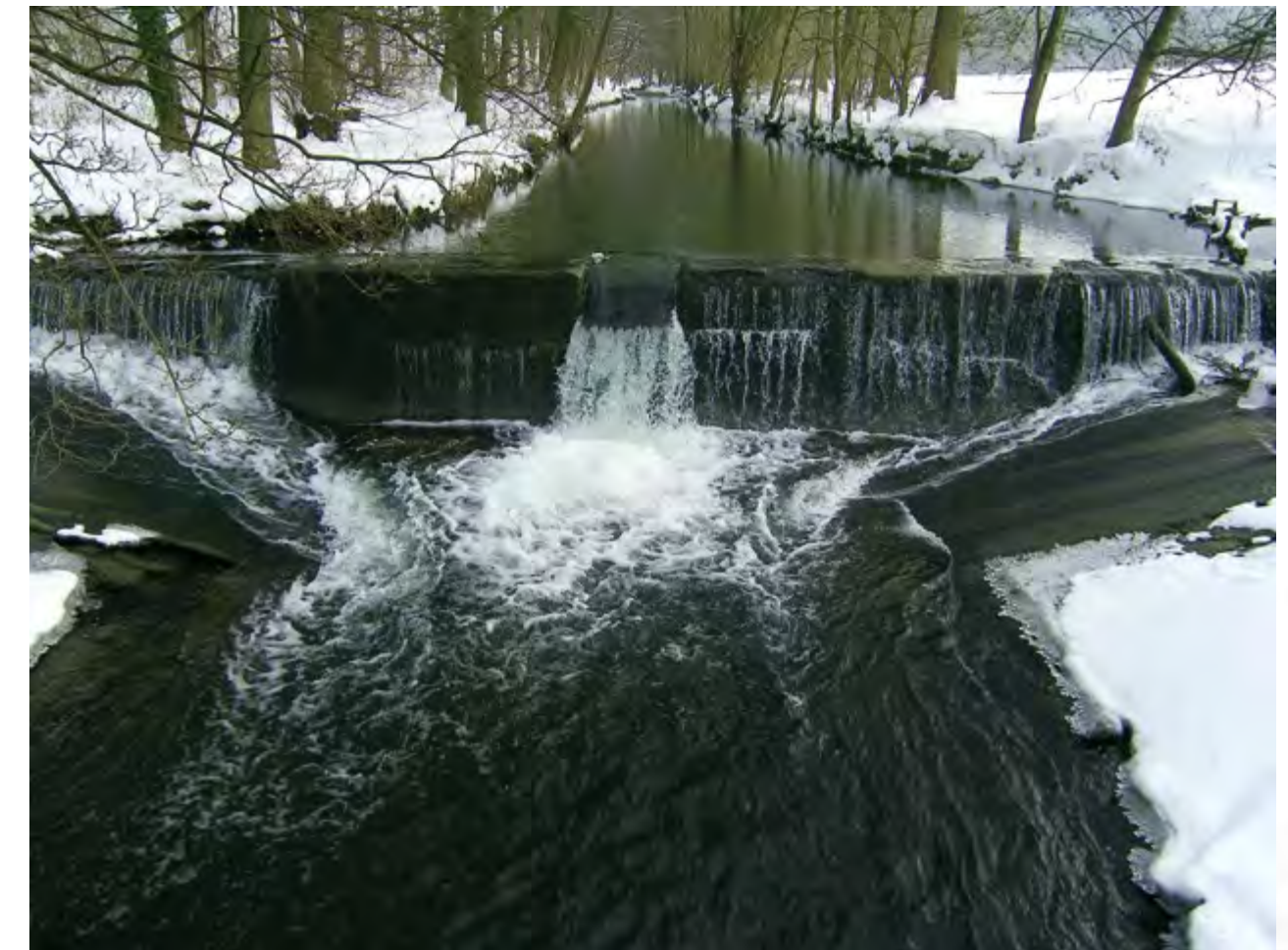
Der alte Zustand des Wehrs im Winter 2010
