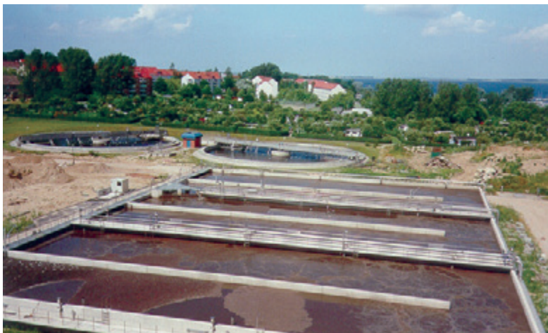
Фото: Активный ил с предварительной денитрификацией
