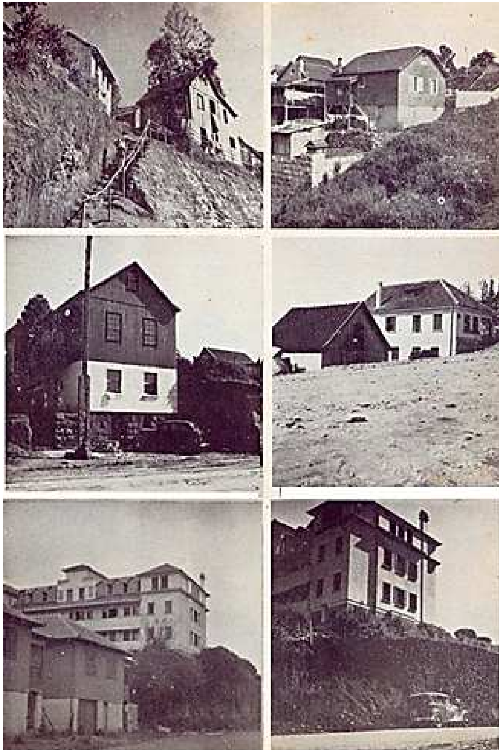
Figura 14 – Obras de corte e aterro decorrentes da aplicação do traçado xadrez
