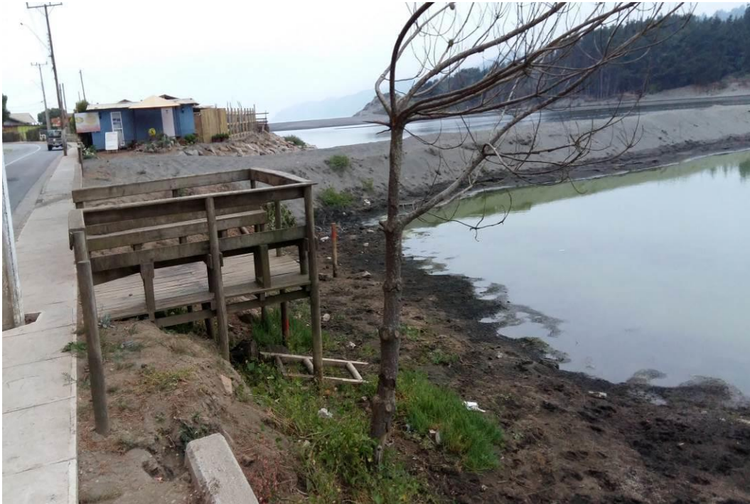
Estaca nivel inundación (Elev. 2.50 m) frente a cortina de arena - Monolito 2
