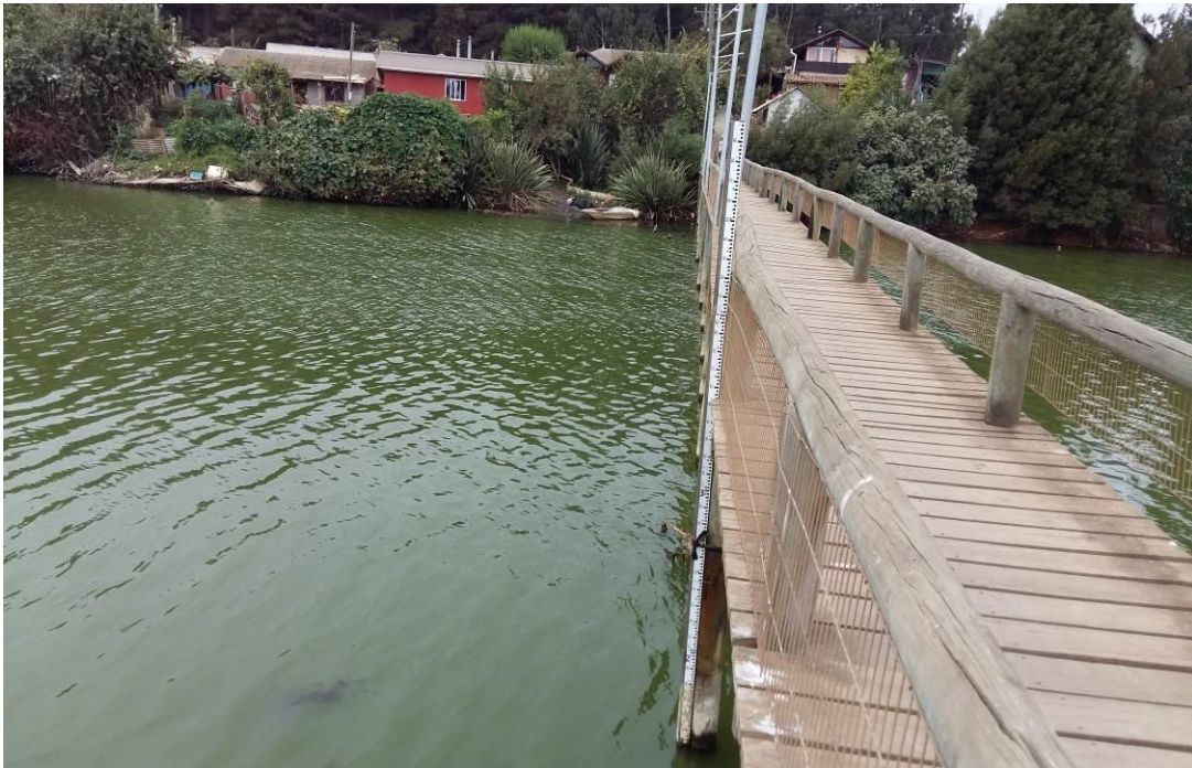
Limnómetro instalado en puente Peatonal las Conchas
