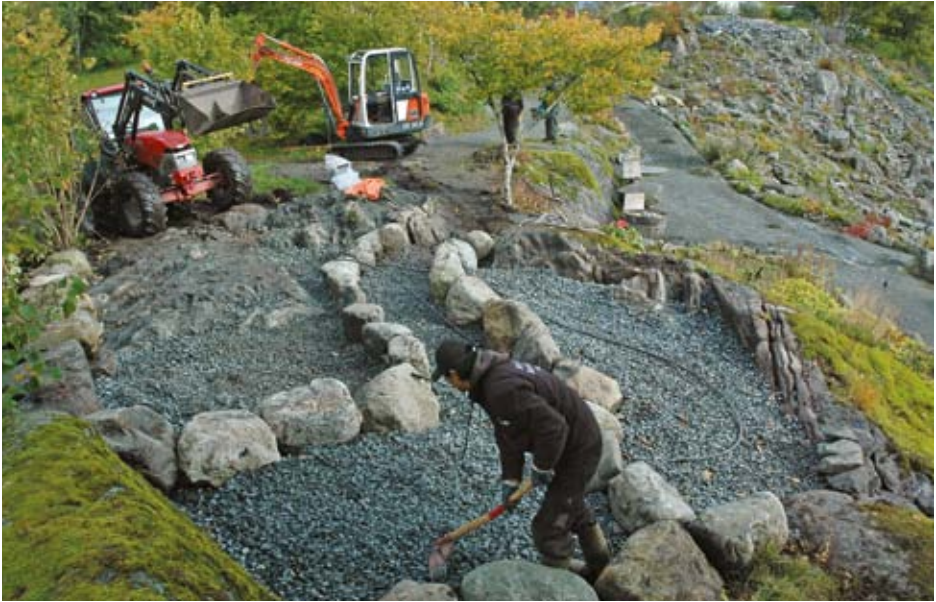
Øverst i Fjellhagen anlegges et nytt felt med tidligblomstrende løkplanter. Paul E. Odfjell i forgrunnen (foto: Bjørn Moe 02.10.2012).
