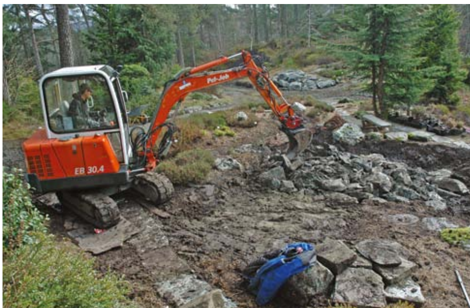
Grunnarbeid i Lynghagen etter kalde vintre og stor utgang av planter. Et nytt felt anlegges og store steiner i bunnen skal sørge for god drenering og relieff til lynglandskapet (foto: Bjørn Moe 29.03.2012).
