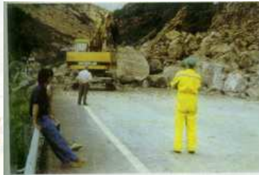
Fig. 18. Corte de una carretera por desprendimiento.
