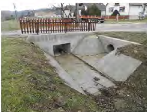
13. sz. fotó: Á-1-1 árok csatlakozása Készítette: Bárdos Zoltán 2015.
