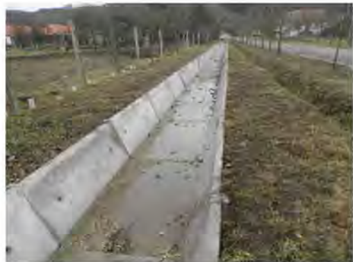
12. sz. fotó: Á-1-1 árok előregyártott elemekből Készítette: Bárdos Zoltán 2015.
