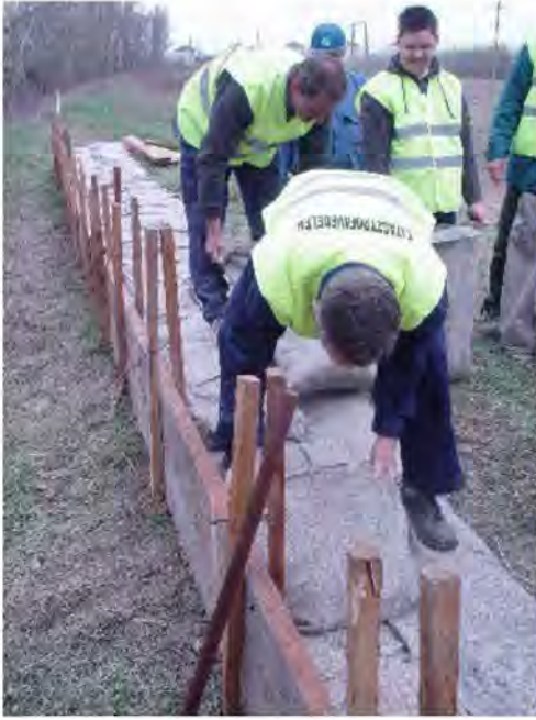
1. sz. fotó: Nyúlgát építése Készítette: Bárdos Zoltán 2010.
