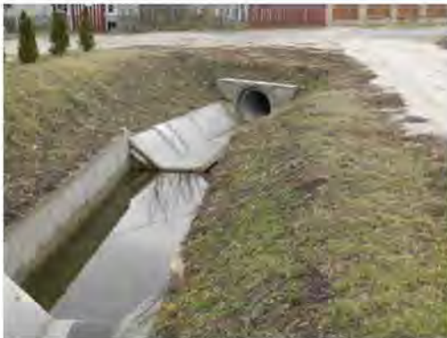
11. sz. fotó: Cs 1-1 zárt csatorna kezdete Készítette: Bárdos Zoltán 2015.
