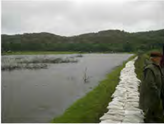
5. sz. fotó: Gátmagasítás nyúlgáttal Készítette: KDT VIZIG 2010.
