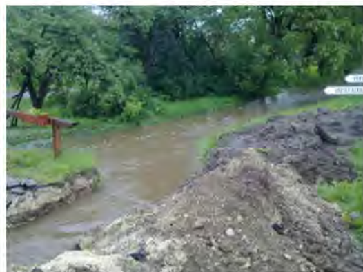
8. sz. fotó: Áteresz felbontása Készítette: KDT VIZIG 2010.
