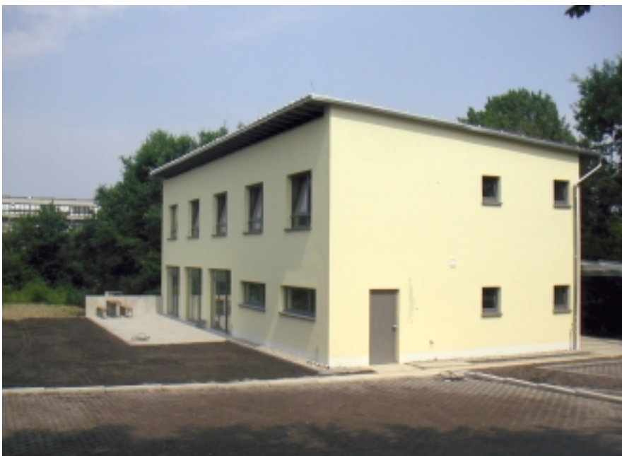
Das neue Verbindungshaus am Vogeliusweg.
