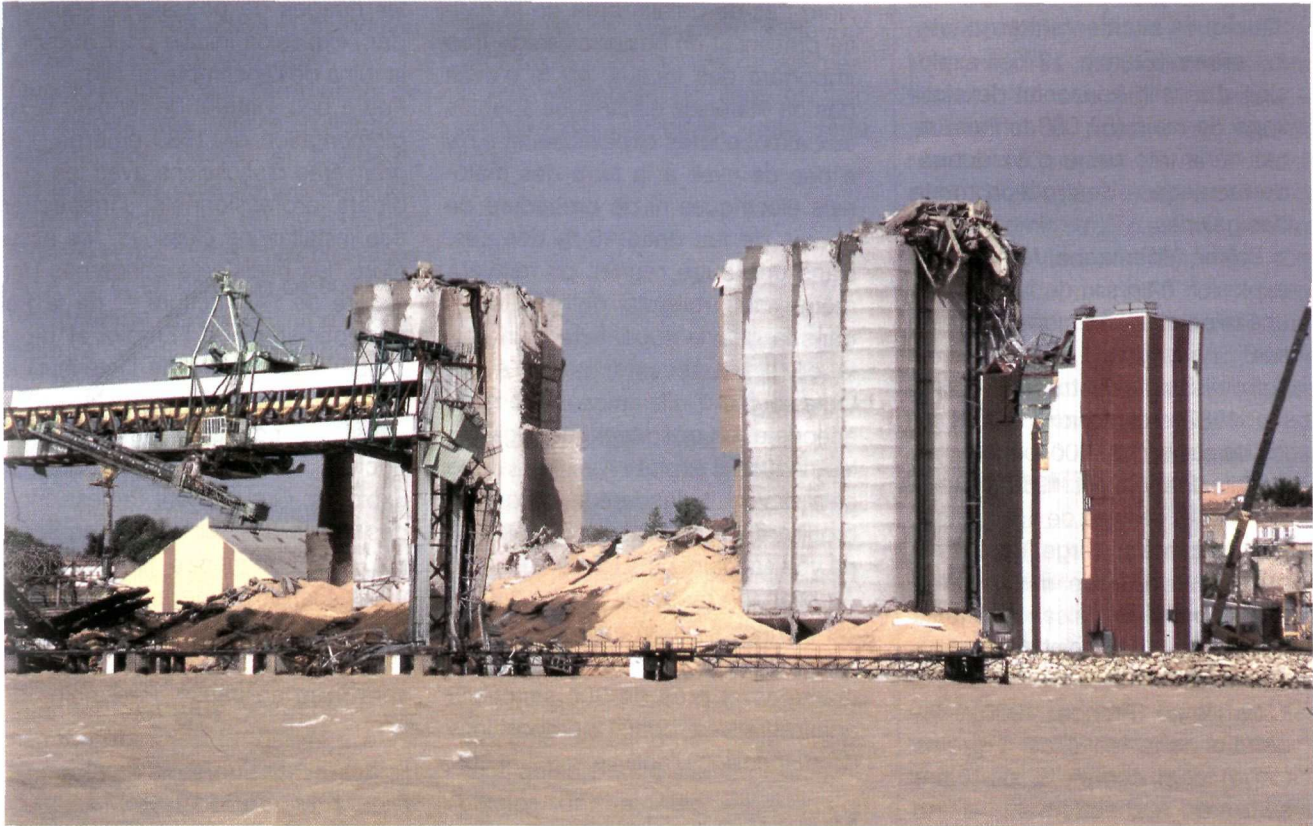
Le silo Semabla à Blaye après l'explosion.
