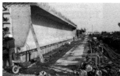
Pont de ST Nazaire Mindin (L.54m - H. 3.10m) Vibrateur externe électrique 4500 T/mn.
