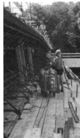
Palais des sports de Mulhouse Poutre à inertie variable (coffrage) Vibrateur externe électrique 4500 T/mn.
