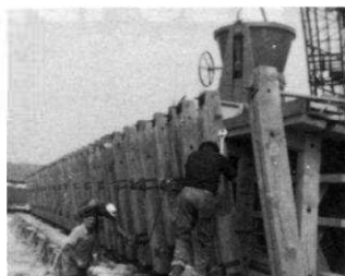
Pont de Cannes Ecluse/s/Seine. Poutre pré-contrainte (coffrage bois). Vibrateur externe électrique 3000 T/mn.
