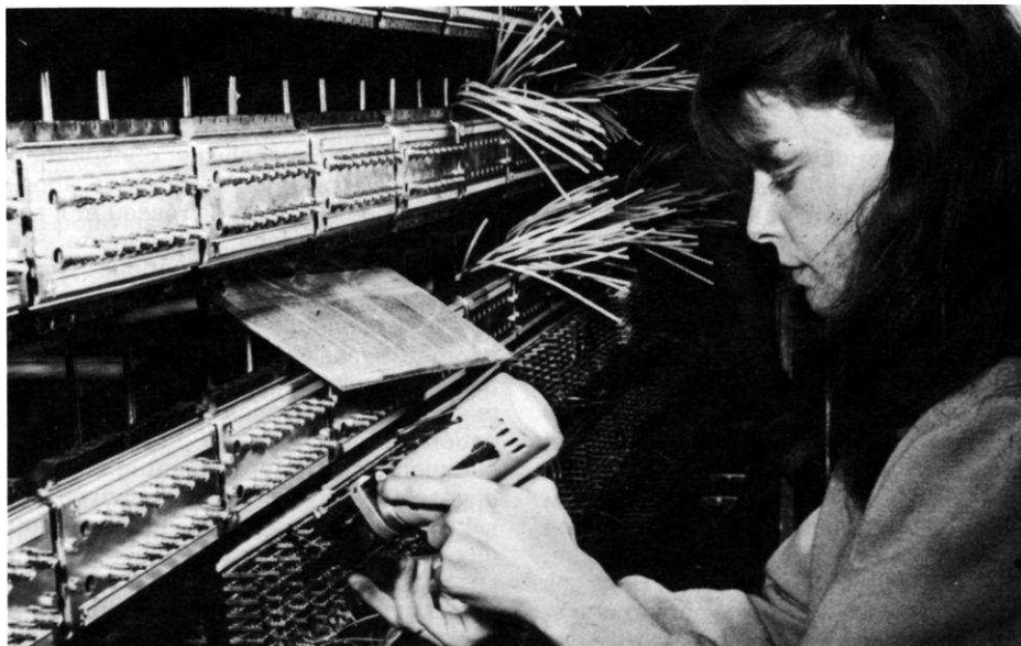
Câblage du 1 er central à fibres optiques
