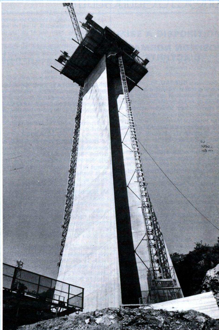
La plus grande pile en construction
