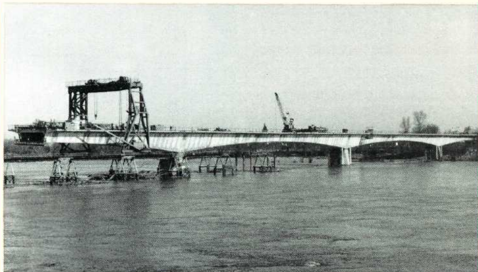
Vue générale de l'ouvrage en cours de construction.
