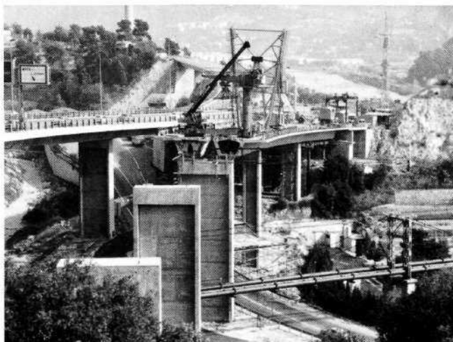
Viaduc de Banquière, dans le fond le tunnel de la Baume.
