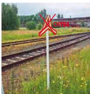
▲ Poškozené označení železničního přejezdu
