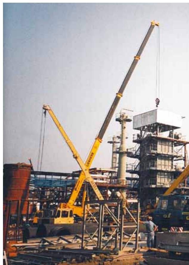
▲ V roce 1995 začala výstavba jednotky hydrogenačního odsíření středních destilátů.
