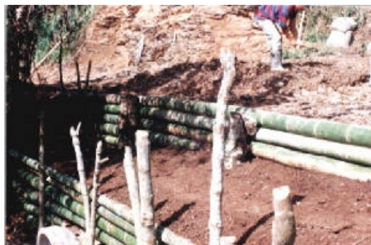
Terraza de estabilización
